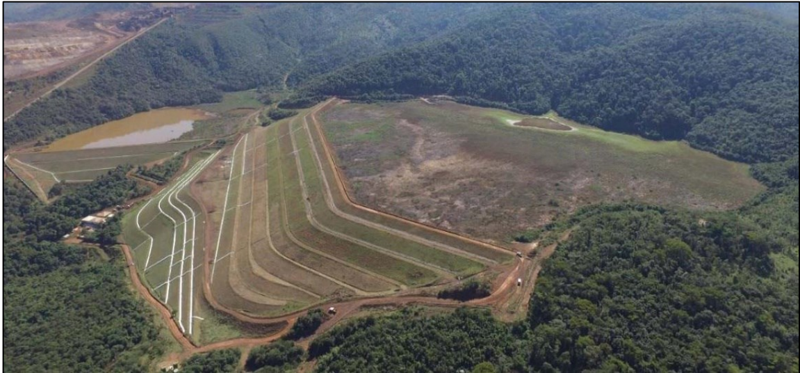
Figura 3.2: Vista aérea da B I; à esquerda, barragem B VI
