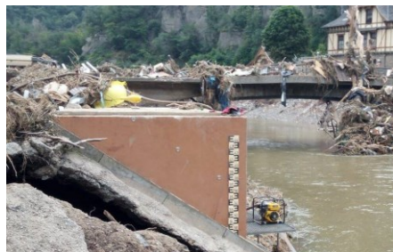
Os restos da régua de medição e da estação em Altenahr após a enchente.
