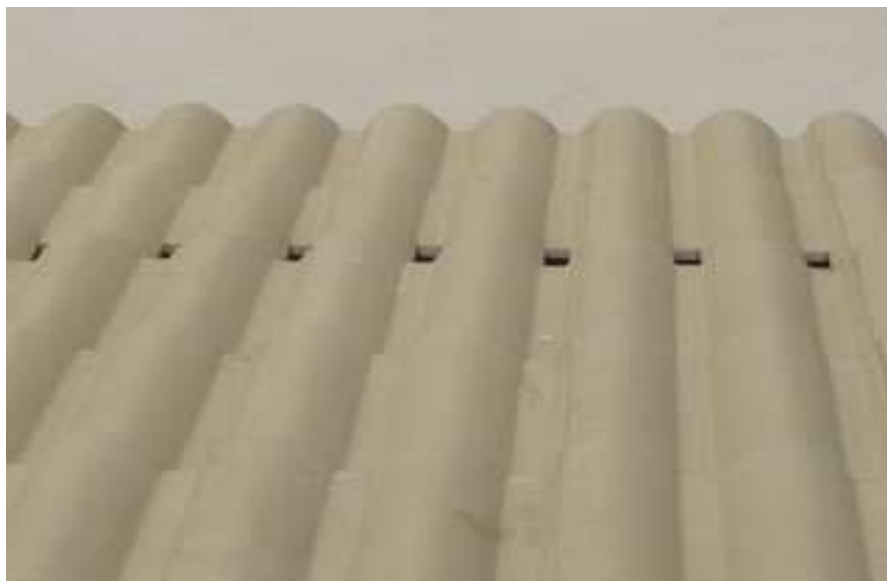
Figura 3.9 - Telha com calha condutora interna para recolhimento de água pluvial Fonte: http://2.bp.blogspot.com/_QopsJ9ZnHSg/SSCwHrf1aLI/AAAAAAAAACK/6_cApR_1qDY/s1600-h/foto+106+Simone.jpg
