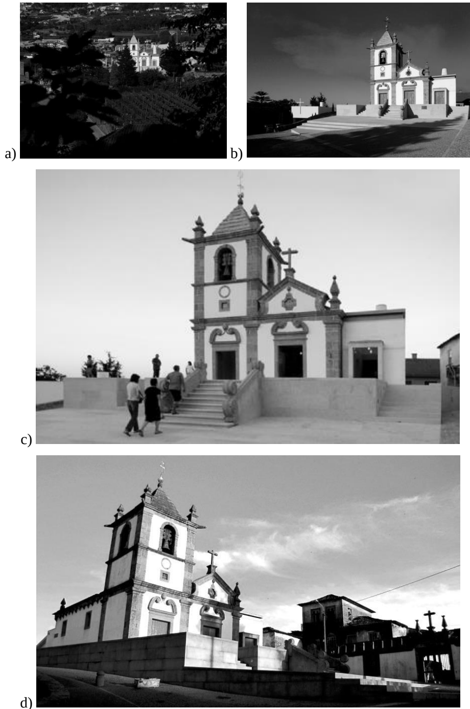
FIGURA 16 – Inserção da Igrejinha de São Salvador, em Figueiredo Braga na paisagem do local
