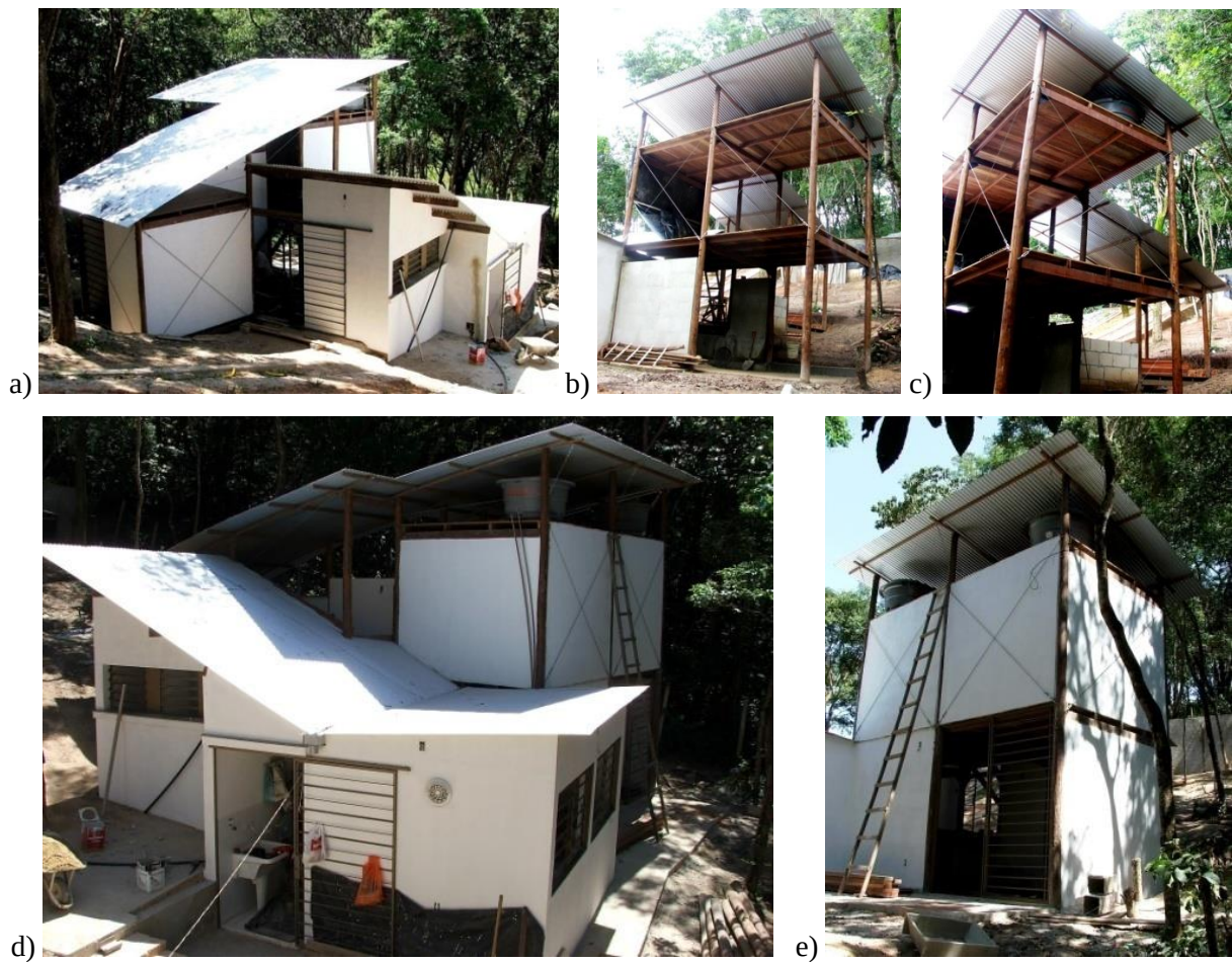
FIGURA 42 – Vistas da construção da casa estruturada com postes de eucalipto
