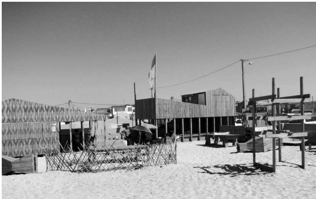
FIGURA 31 – Vista do pavilhão de madeira proposto e construído coletivamente com a comunidade da Cova do Vapor, – pelo coletivo EXYZT
