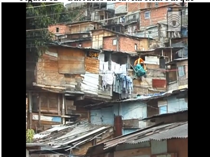
Figura 12 – Barracos da favela Real Parque
