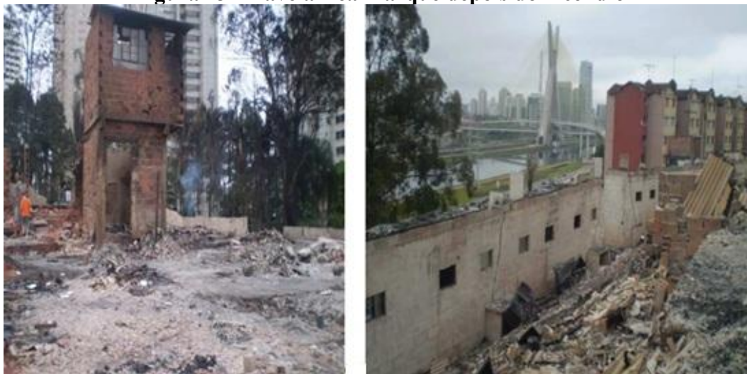
Figura 23 – Favela Real Parque depois do incêndio
