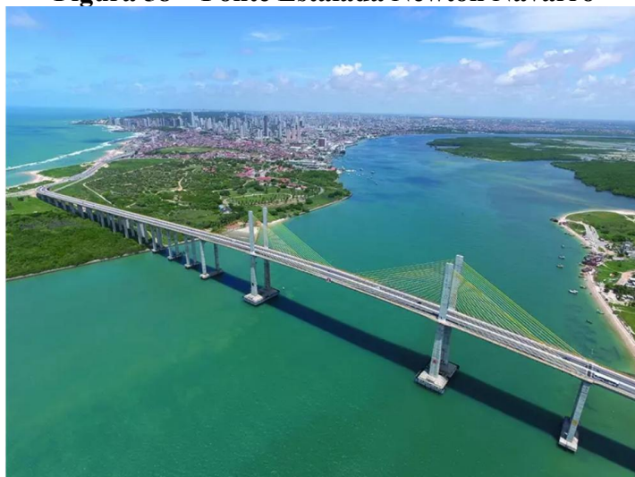
Figura 58 – Ponte Estaiada Newton Navarro
