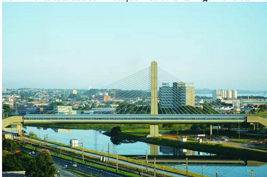
Figura 54 – Ponte estaiada com Estação Metroviária Engenheiro Jamil Sabino
