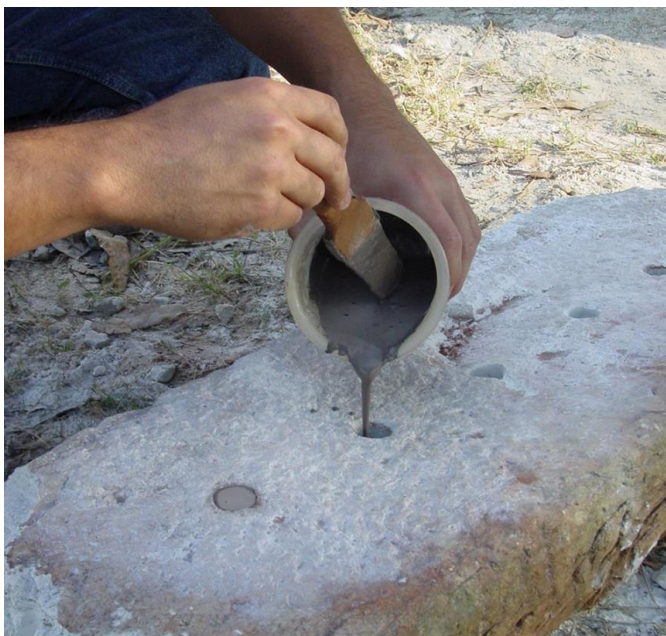
Figura 1 – Operação de carregamento dos furos com a argamassa expansiva
