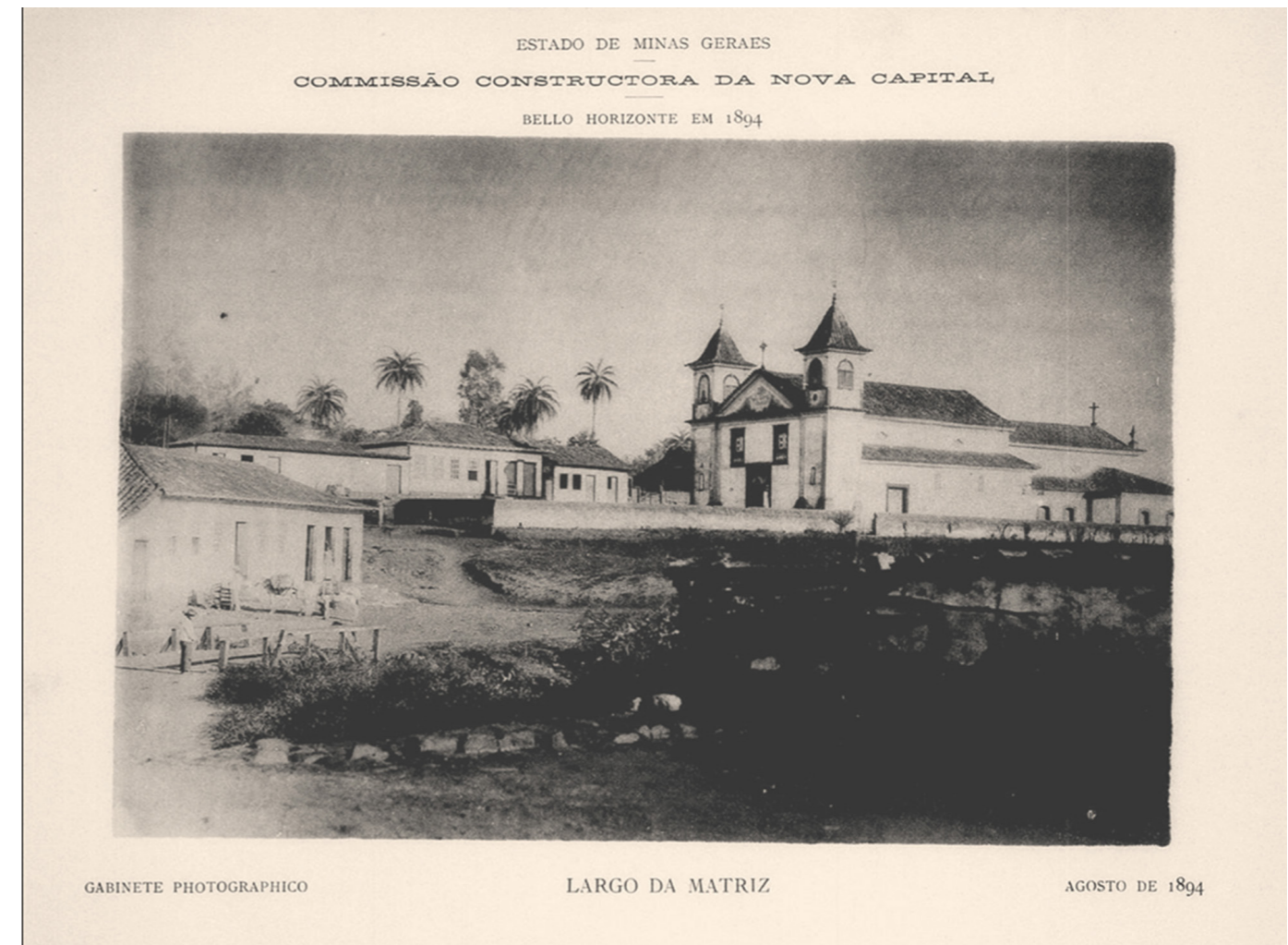
Figura 4: Largo da Matriz. Gabinete Fotográfico, 1894. Revista Geral dos Trabalhos.
