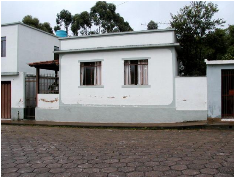
Figura 3 – Estrutura arquitetônica da unidade A
