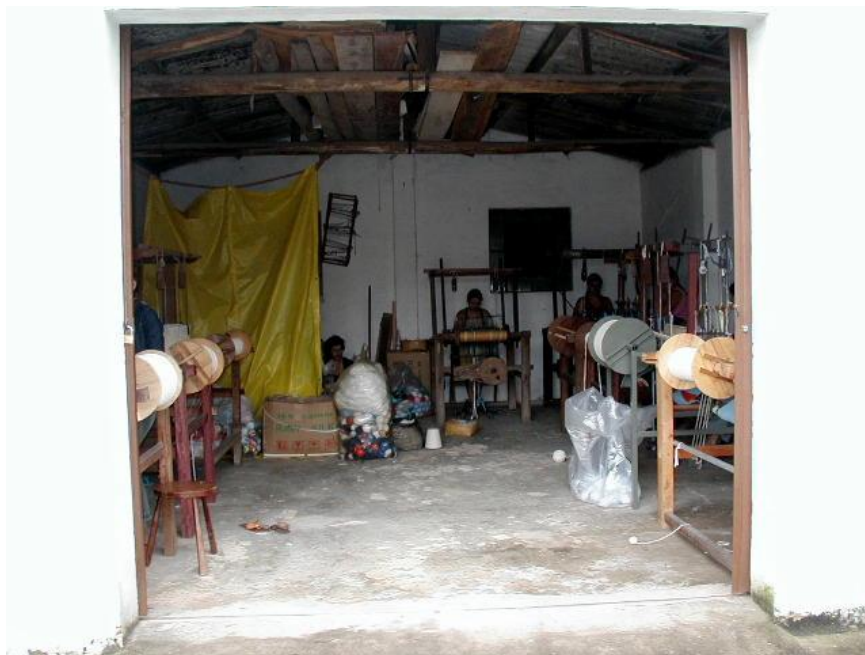
Figura 5 – Estrutura arquitetônica da unidade B
