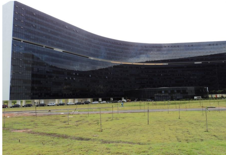
Figura 4: Prédio Minas ao fundo e à frente o Centro de Convivência.
