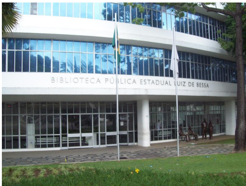
Figura 10 : Biblioteca Pública Estadual Luiz de Bessa.
