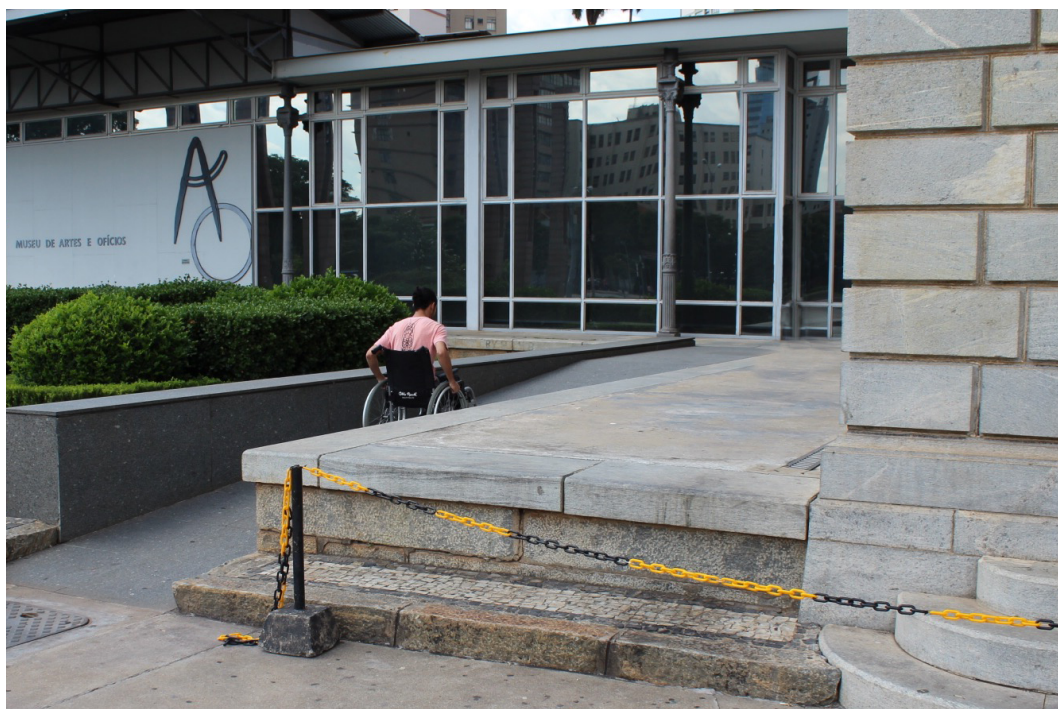
Figura 106: Rampa de acesso para pessoas com deficiência localizada no lado externo do museu. 151
