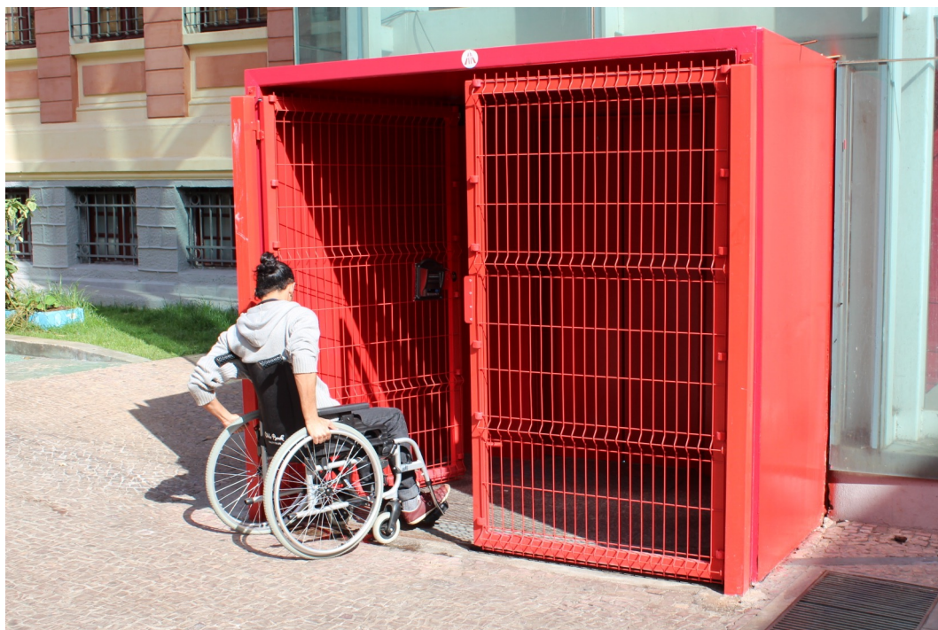
Figura 111: Piso irregular e espaço de aproximação restrito dificultam o uso do elevador. 156
