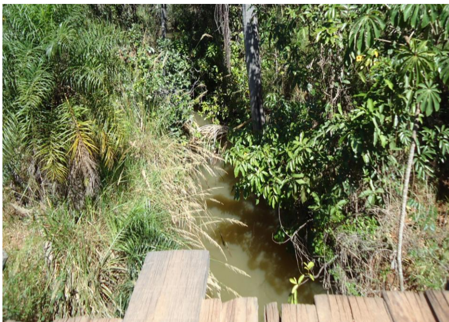
FIGURA 9- Travessia com ponte na vereda
