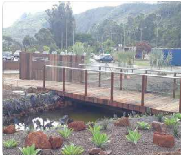
Figura 2 e 3 - Pontes e muretas construídas com dormentes e expurgo de minério Fonte: Autor, 2017.
