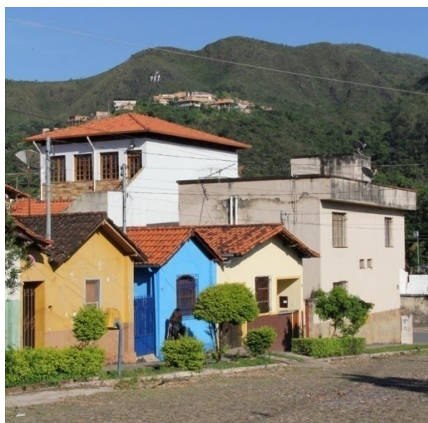
Figura 31: Construção de telhado na Rua Nossa Senhora do Ó - Em 21/03/2012
