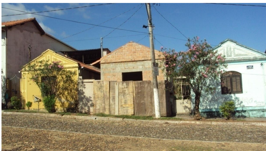
Figura 34: Reconstrução da casa de número 78, no Largo do Ó – Em 02/2012
