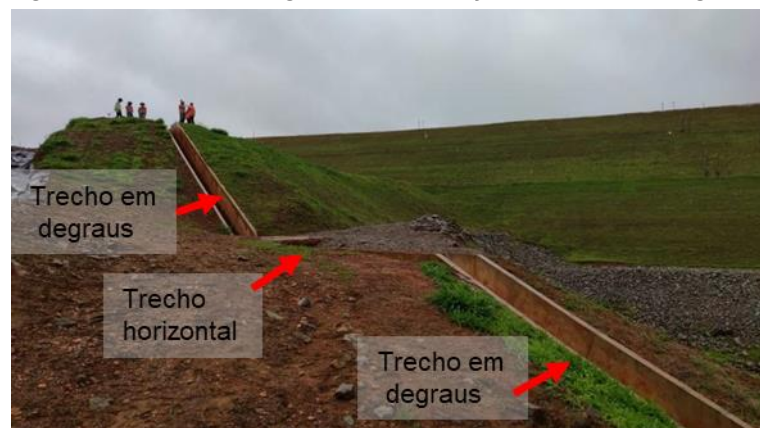
Figura 4 - Drenagem lateral de barragem de mineração: descida de água em três trechos.
