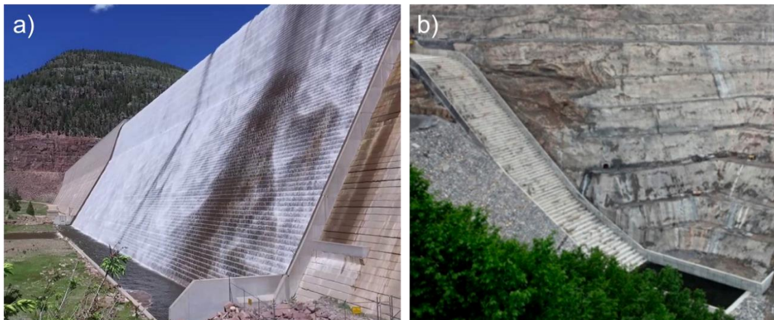
Figura 31 – a) Barragem Upper Stillwater, “córrego” Rock Creek, Utah, EUA; b) Barragem Siah-Bishe, rio Chalus, Mazandaran, Irã.
