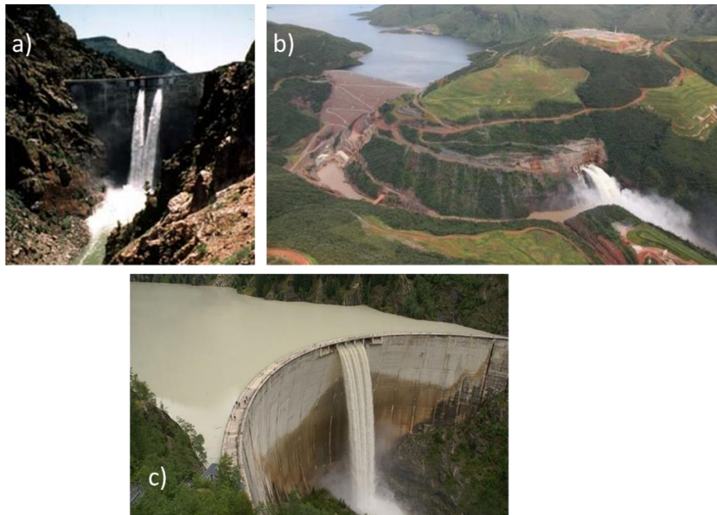
Figura 36 – Exemplos de jatos como estruturas extravasores de queda livre: a) Barragem Morrow Point, rio Colorado, Cimarron, EUA; b) Barragem Irapé, rio Jequitinhonha, Grão Mogol, Brasil; c) Barragem Stausee Gibidum, rio Massa, Naters, Suíça.
