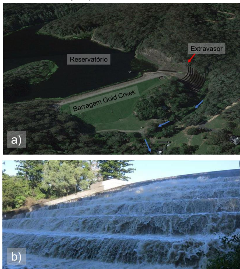
Figura 1– a) Localização do extravasor da Barragem Gold Creek, em Brisbane, Austrália; b) Extravasor em operação em 02/05/2015, evento de 162 mm.
