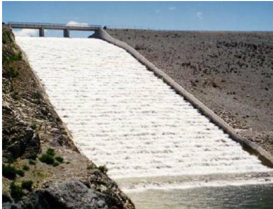
Figura 13 – Nappe Flow : Extravasor da Barragem Opuha, no rio Opuha em Canterbury – Nova Zelândia.
