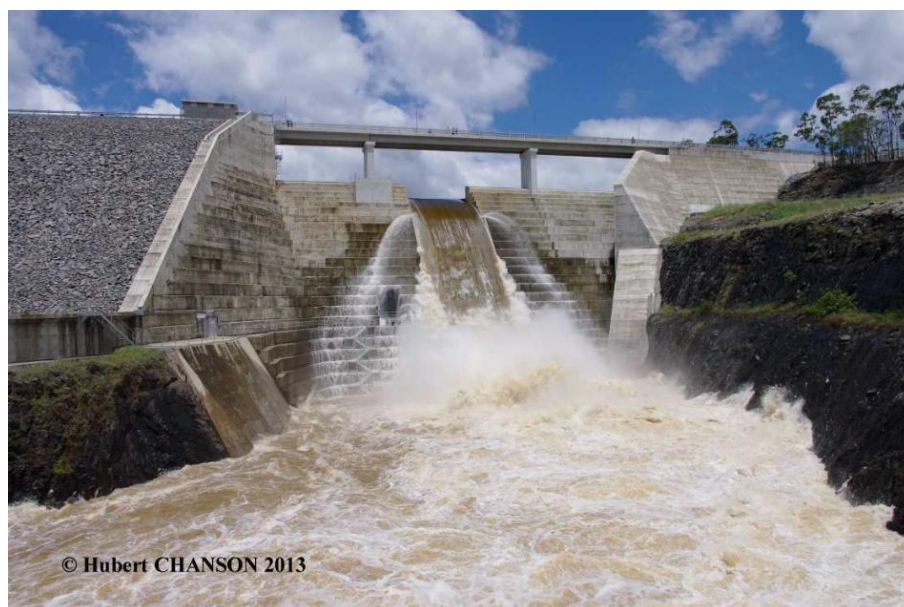
Figura 2 – Descida em degraus da barragem de contenção de cheias Hinze, em Gold Coast, Austrália.
