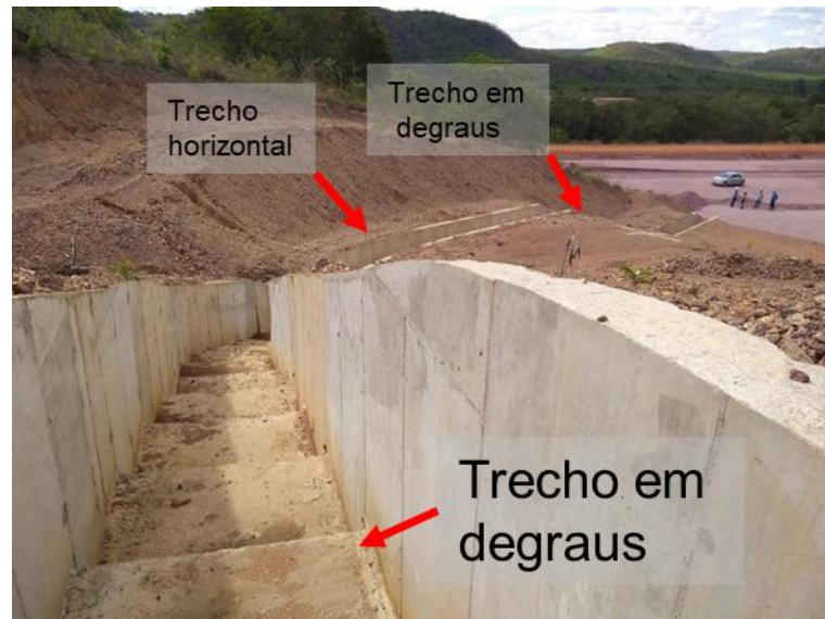
Figura 3 - Descida em degraus em canal periférico de uma pilha de rejeitos em construção.
