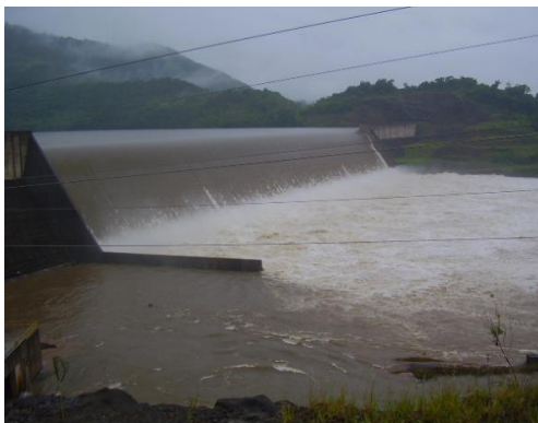
Figura 15 – Skimming Flow : Vertedouro da Barragem da Usina Hidrelétrica Dona Francisca, rio Jacuí, Rio Grande do Sul, Brasil.
