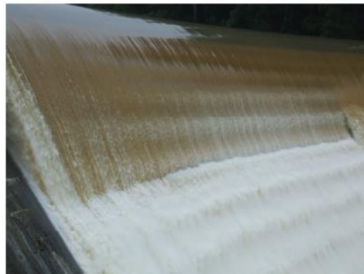
Figura 16 Nappe Flow na barragem Chichester, no rio Chichester, Austrália.
