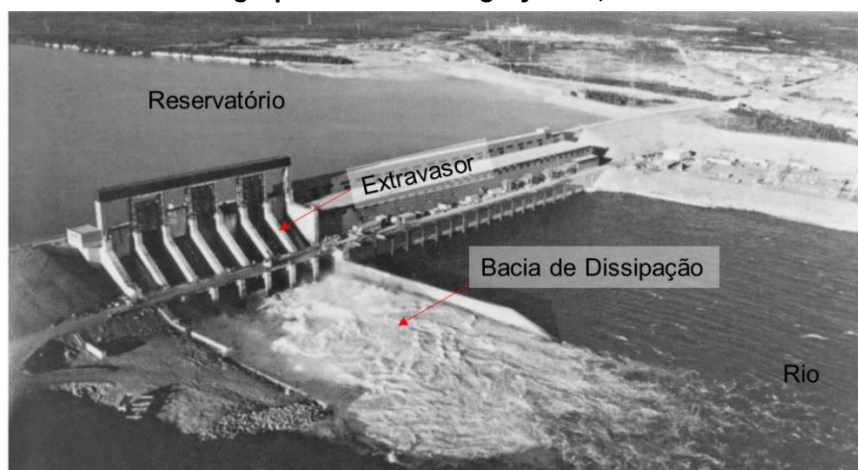
Figura 39 – Canal extravasor com bacia de dissipação por ressalto hidráulico da Barragem Limestone no Long Spruce Generating System, rio Nelson - Canadá.
