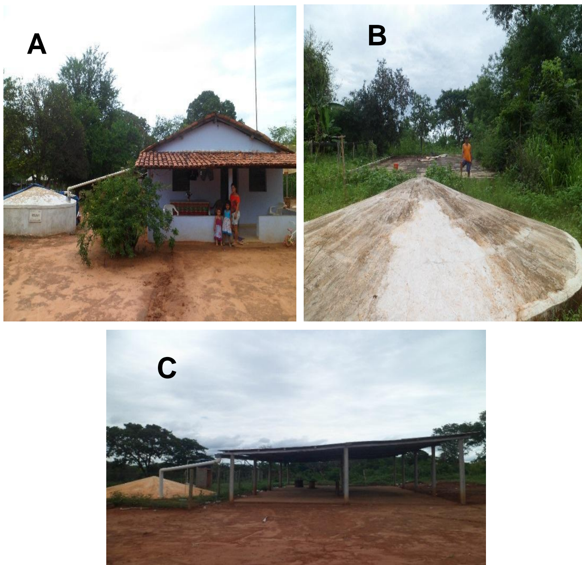
Figura 7: Cisternas de placas (A), calçadão (B) e telhadão (C) que utilizam água proveniente das chuvas localizadas nas comunidades de Araçá e Onça em Januária, MG. Fonte: pesquisa de campo, 2017
