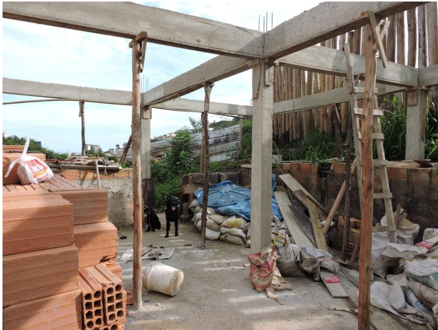
Figura 60 - Estrutura para a construção da laje destinada à moradia de Janaína
