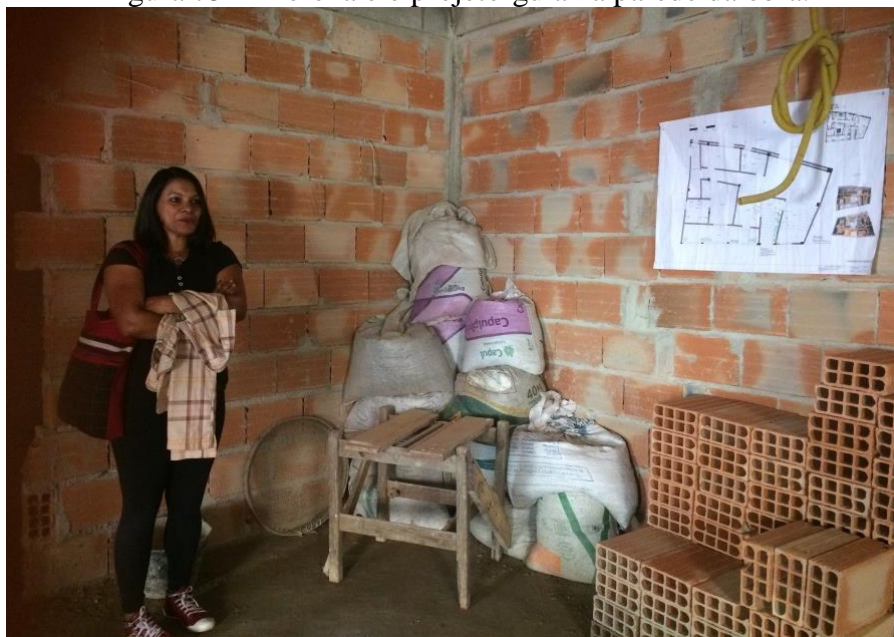
Figura 75 – Morena e o projeto-guia na parede da obra.
