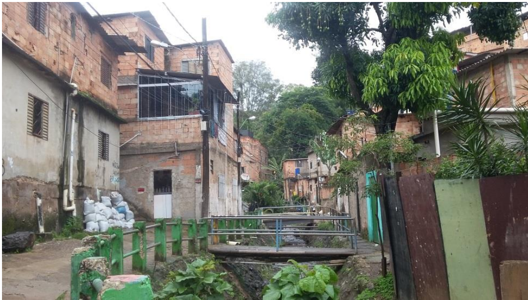
Figura 18 - Beco da Mina em novembro de 2016.
