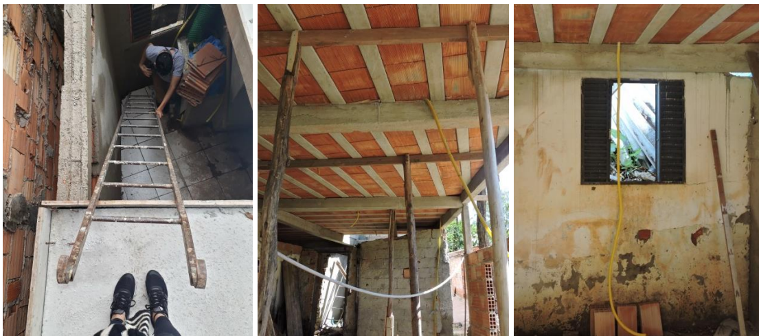
Figura 71 – Caixa de escada, escoras e parede na encosta de terra.
