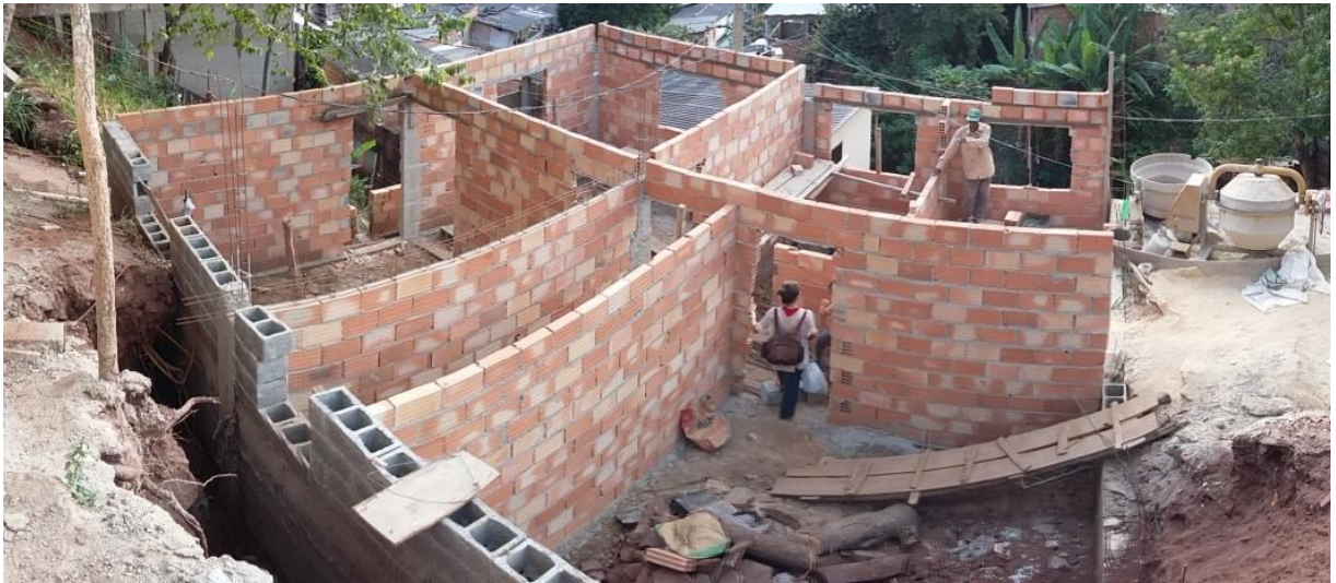
Figura 43 - Visita à obra um mês após a dinâmica.
