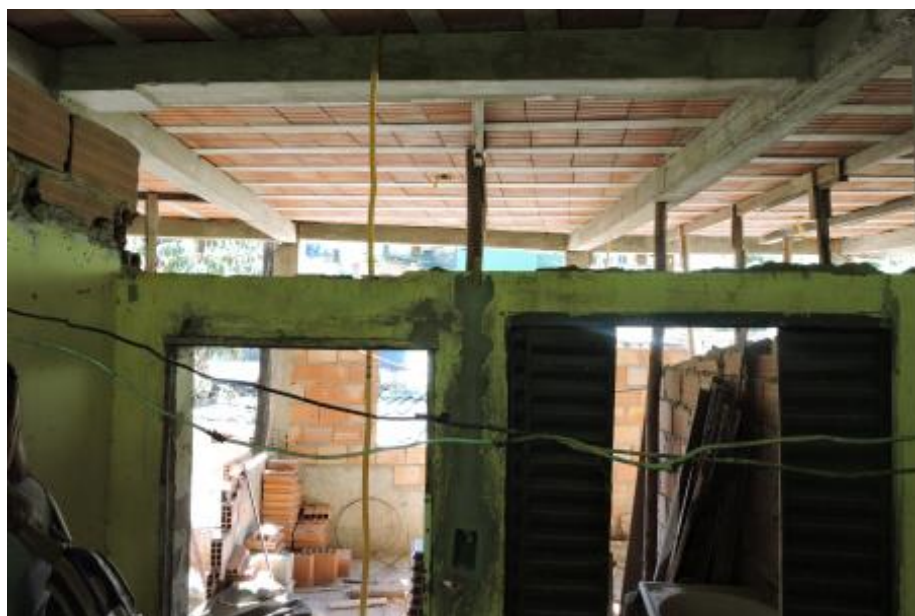
Figura 70 – Paredes a serem demolidas e laje já construída.
