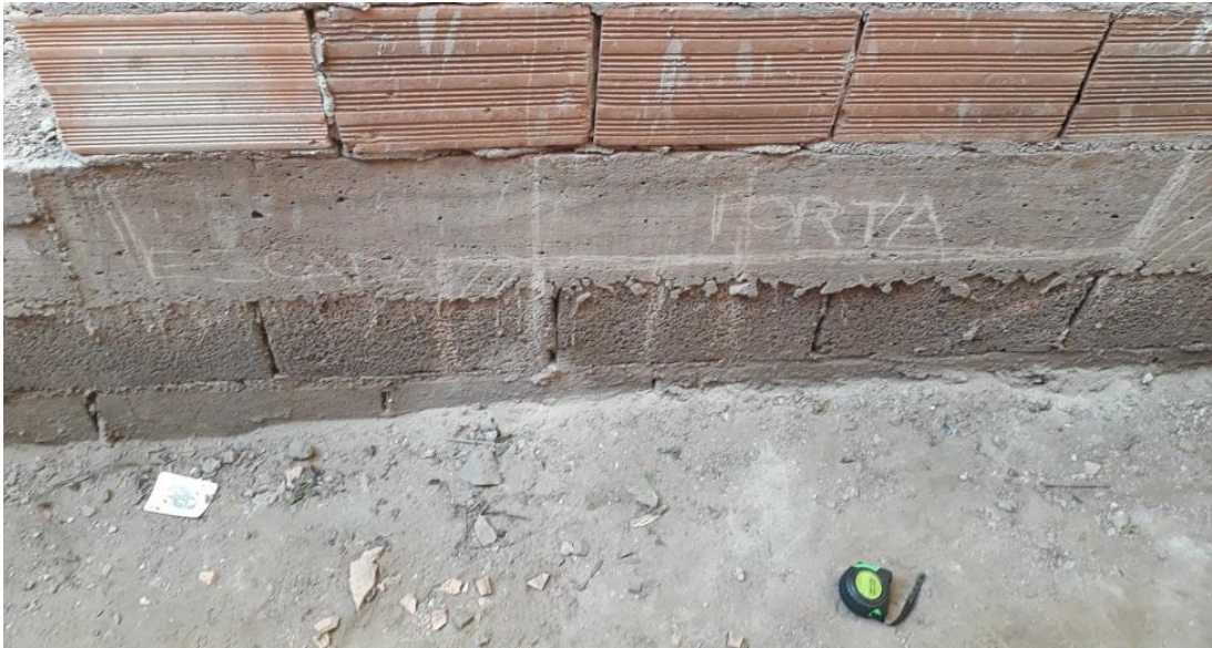
Figura 50 – Locação da escada na obra, realizada junto aos moradores.
