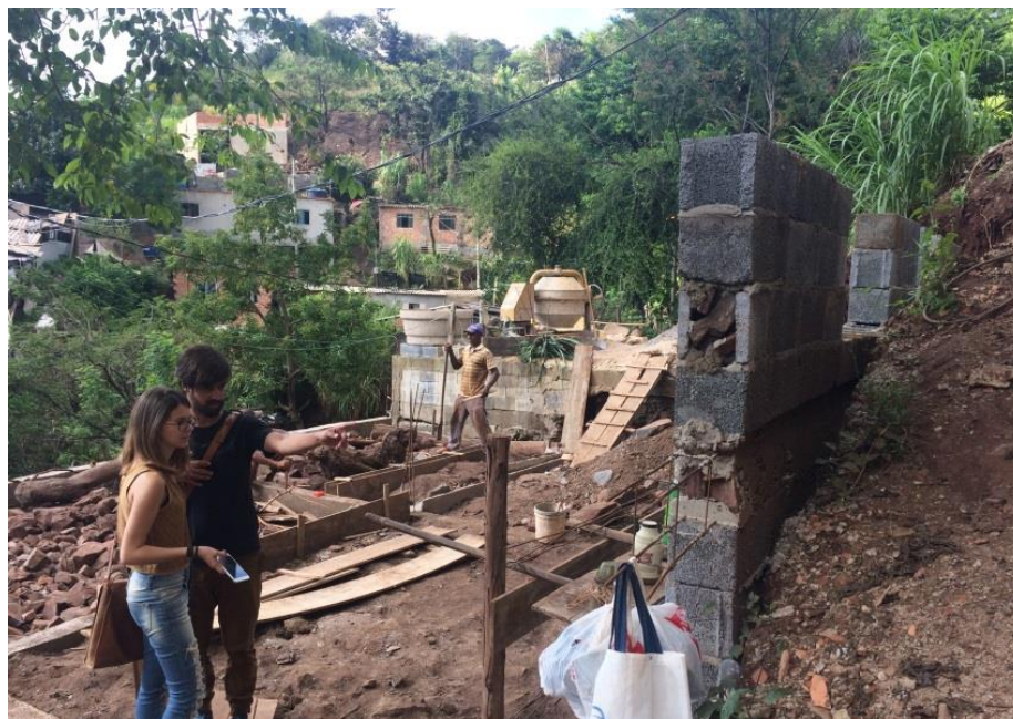
Figura 41 – Corte posterior ao terreno e muro de contenção.
