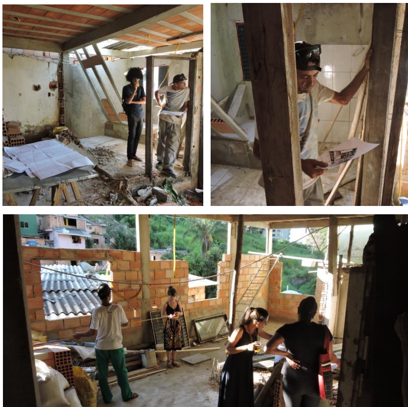
Figura 73 – Pedreiros da construção de Morena participando do processo de projeto.
