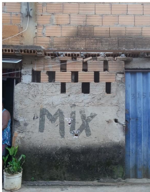
Figura 44 – Solução de iluminação e ventilação em moradia localizada na Vila Acaba Mundo.
