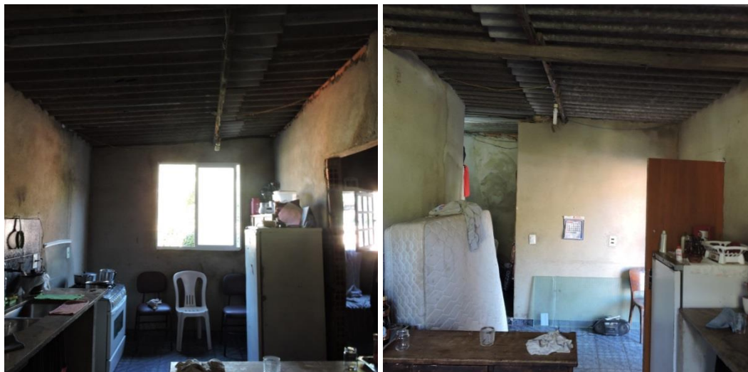
Figura 77 – Moradia da Cláudia (parte interna).
