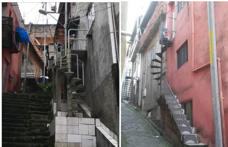
Figura 81 - Registro de soluções destinadas a escadas. Fotografias obtidas no Conjunto Habitacional Gazuza, em Diadema-SP.
