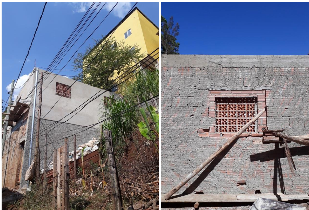
Figura 52 – Fotografias, externa e interna, da construção de Beatriz, em setembro de 2017.
