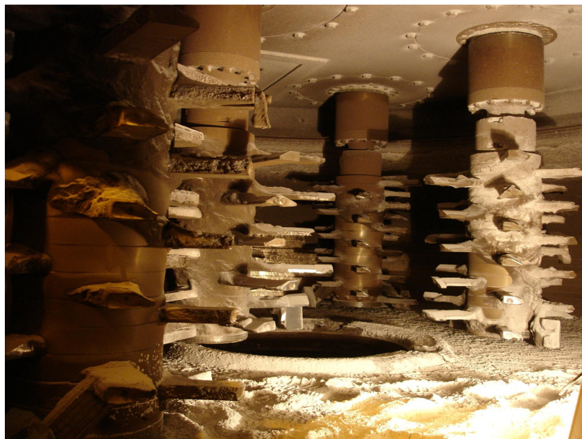
Figura 3.8 – Parte interna do misturador (CSA/Outotec)
