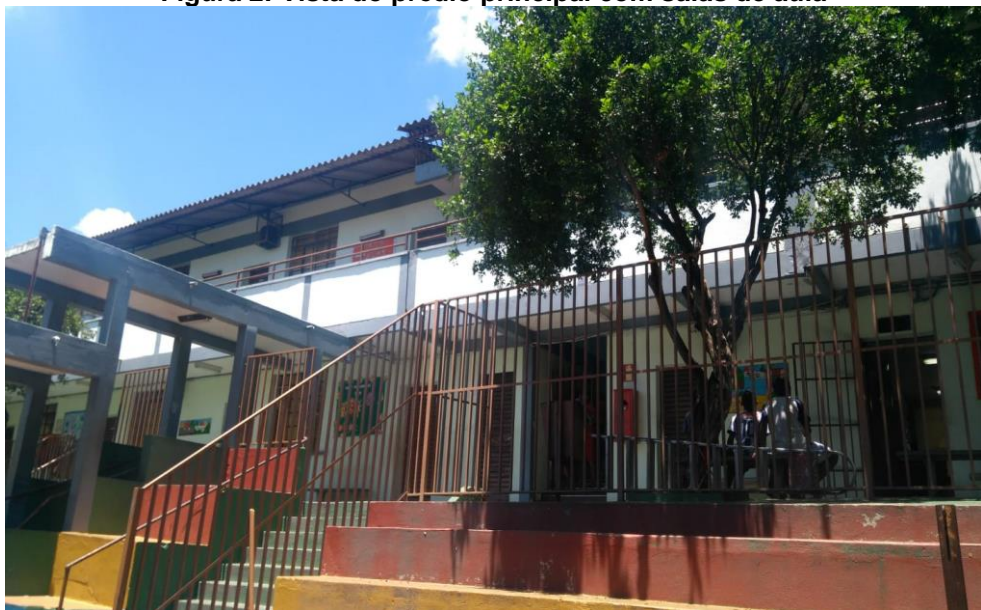
Figura 2: Vista do prédio principal com salas de aula
