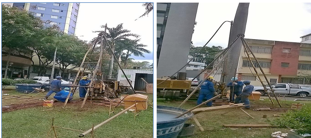
FIGURA 35 – Sondagem do terreno na Avenida Pasteur na região hospitalar
