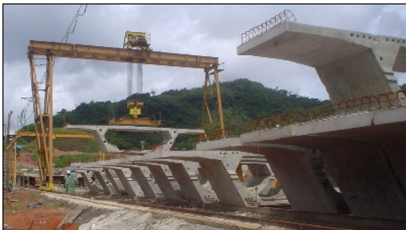
FIGURA 22 – Movimentação de aduelas pré-fabricadas (Fonte: arquivo do autor)
