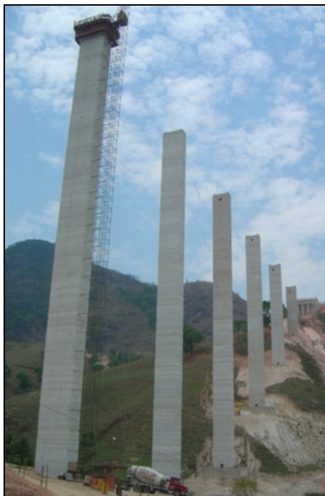
FIGURA 24 – Execução dos pilares do viaduto (Fonte: arquivo do autor)
