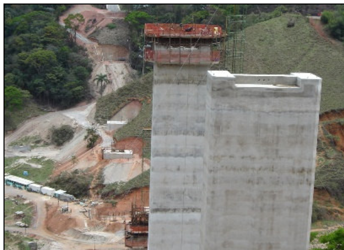
FIGURA 23 – Topo dos pilares projetados para o lançamento das aduelas (Fonte: arquivo do autor)
