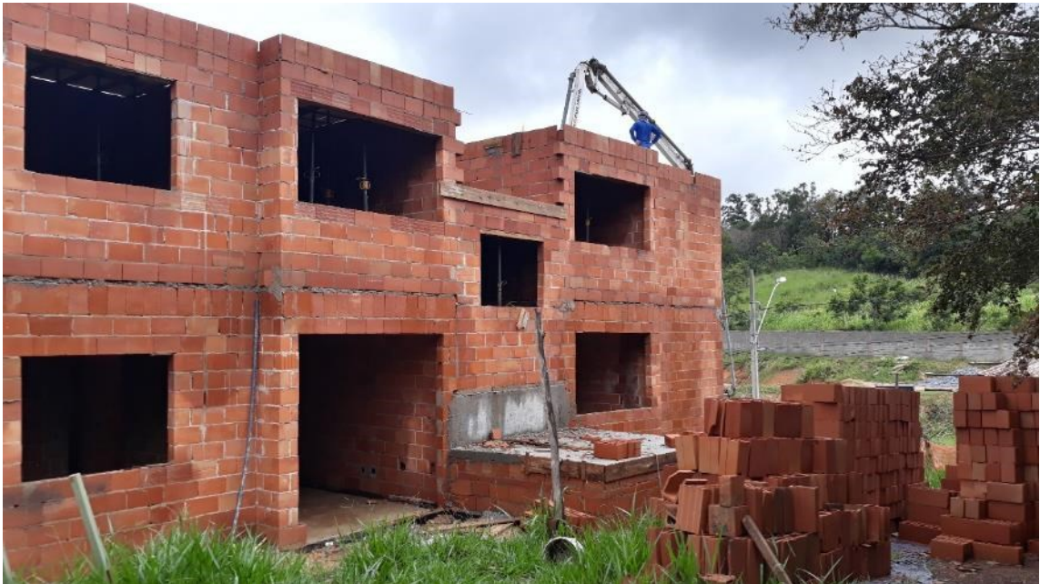
Figura 7 – Concretagem de laje pré fabricada treliçada. Detalhe na viga de concreto armado. Fonte: Arquivo do autor
