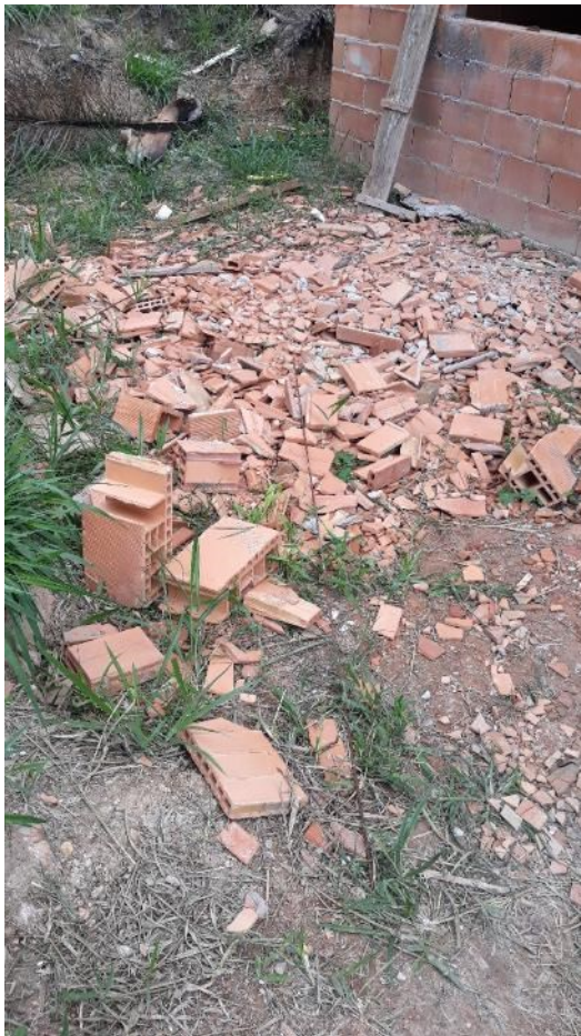
Figura 1 – Desperdício de blocos estruturais no canteiro – Fonte: arquivo do autor
