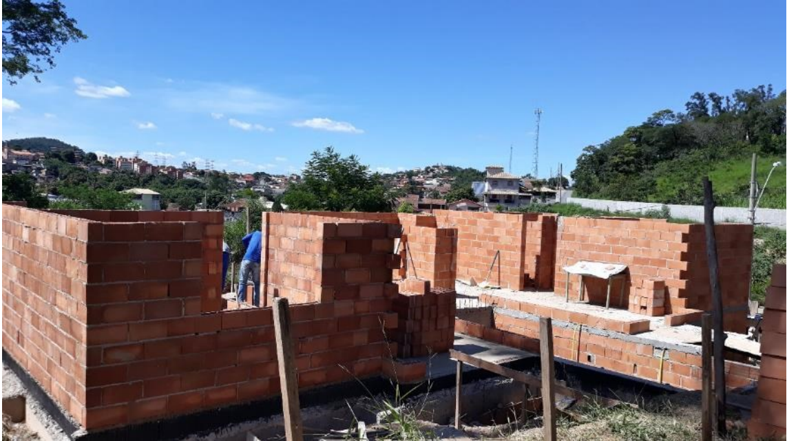
Figura 6 – Execução da superestrutura em alvenaria estrutural. Fonte: Arquivo do autor
