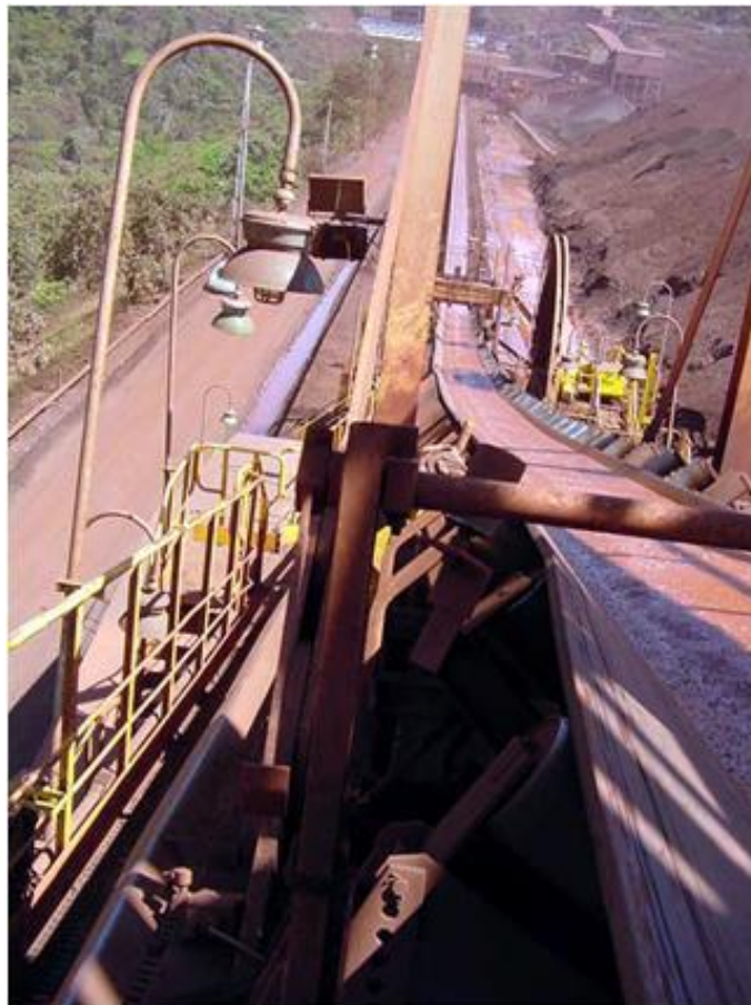
Figura 2.7 - Correia transportadora de minério
