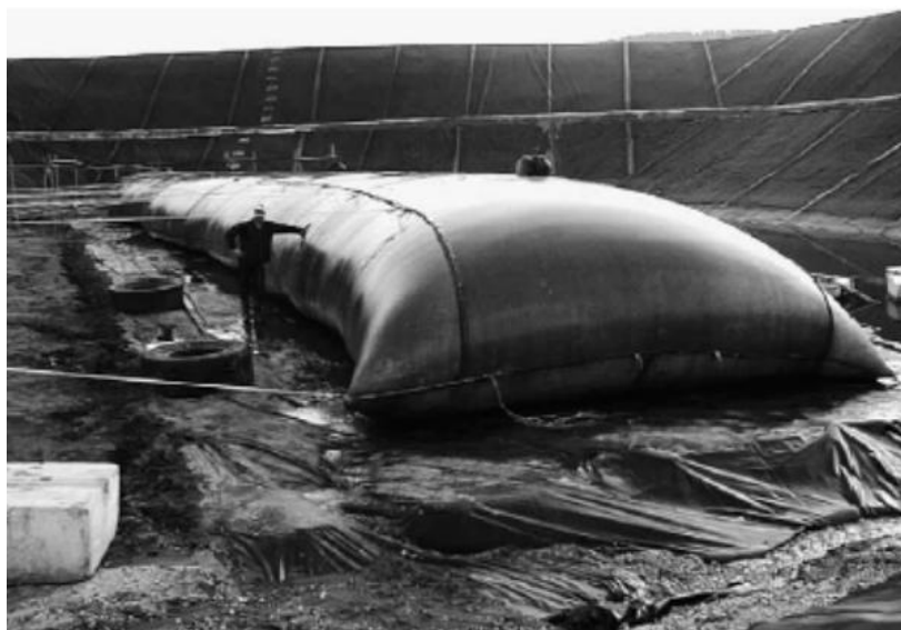
Figura 2.28 - Desaguamento de rejeito de mineração em tubos de geotêxteis (VIDAL e MARTINS, 2006)
