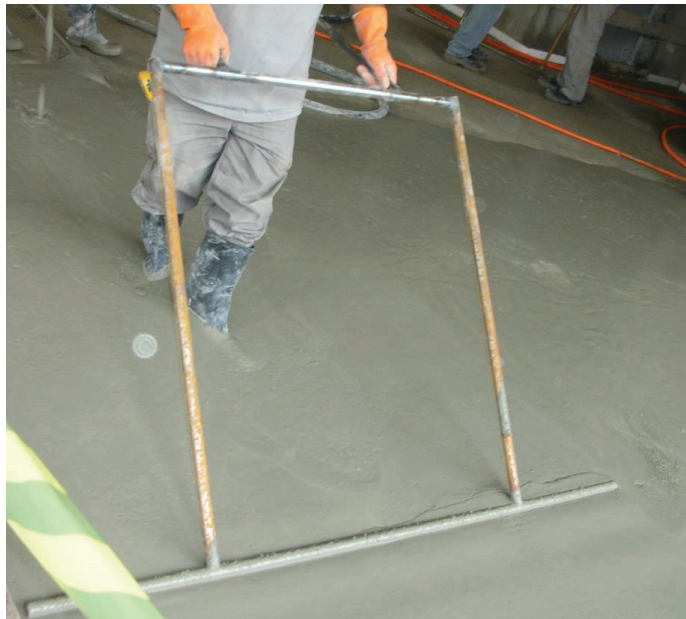
Figura 4-3 - Régua “T” para regularização da superfície de CPA
