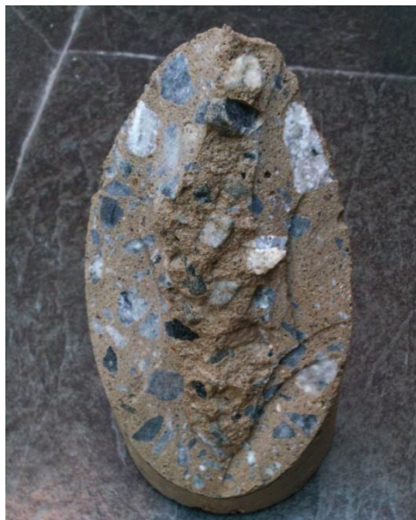
Figura 6-22 - Corpo de prova de concreto convencional seccionado com a parte interna apicoada.
