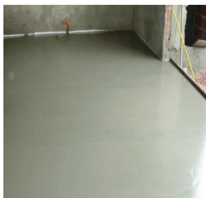
Figura 5-4 - Contrapiso autonivelante pronto
