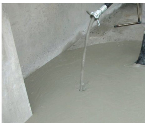
Figura 5-3 - Lançamento do contrapiso autonivelante
