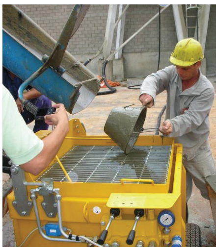
Figura 5-1 - Bombeamento da argamassa
