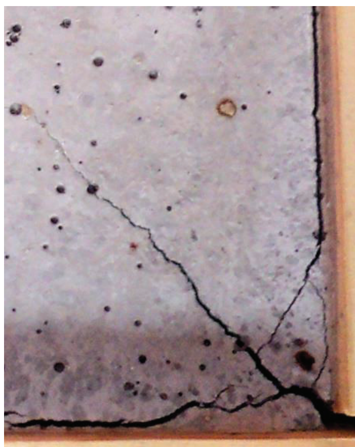
Figura 7-23 - Imagem ampliada Mri- detalhe 4
