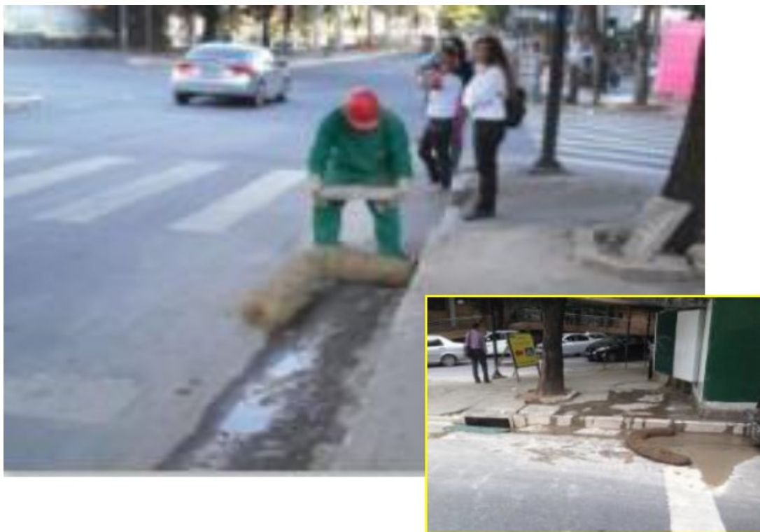
Foto 14 - Controle de saídas de sedimentos: proteção das bocas de lobo
