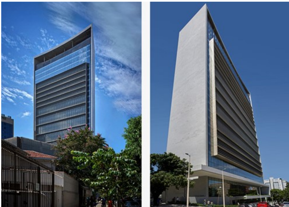
Foto 2 - Fachada Norte do edifício caso de estudo certificado LEED
