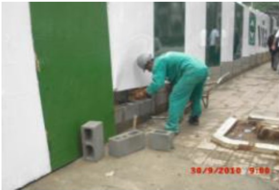
Foto 15 - Controle de saídas de sedimentos: vedação da base do tapume
