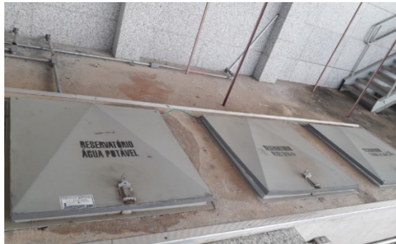
Foto 24 - Água potável para paisagismo, reduzir 100%: reservatórios de água potável, de água de reuso e de água de irrigação
