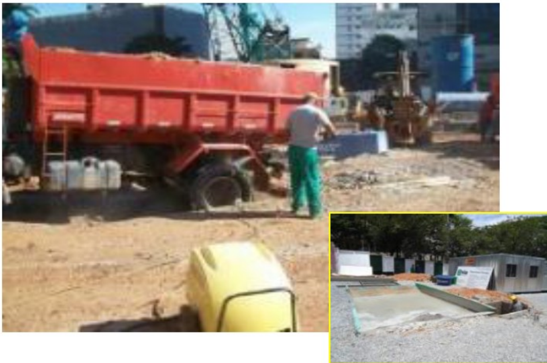
Foto 16 - Controle de saídas de sedimentos: sistema de lava rodas
