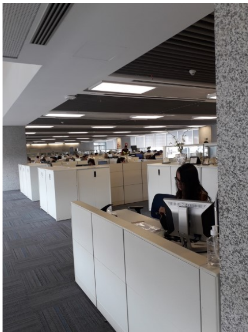
Foto 27 - Otimizar eficiência energética 21%: sistema de iluminação das áreas de trabalho
