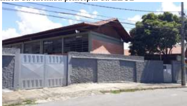
Fig.2 – Panorâmica da fachada principal da EECB
