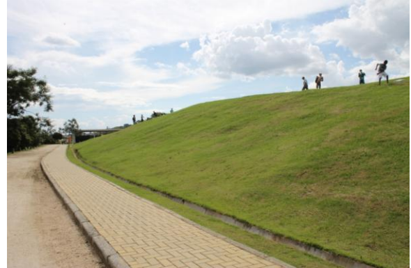
FIGURA 51 – Talude bloqueia visão da Esplanada Fonte: Arquivo da autora, 2011.
