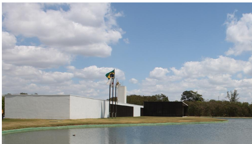
FIGURA 24 – Edificação do Centro de Apoio e Espelho D'água Fonte: Arquivo da autora, 2011.
