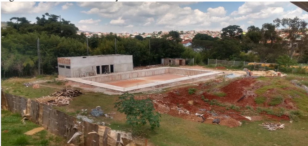
Figura 8: Piscina em construção.
