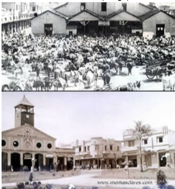
Foto 61 - Mercado Central (antigo) demolido
