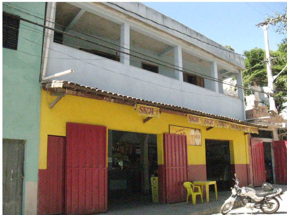
FIGURA 22: Edificação comercial na Praça Carioca. Fonte: Produzida pelo autor. 2010
