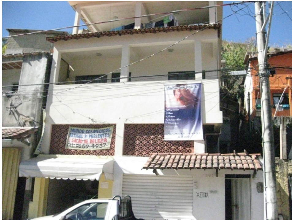
FIGURA 23: Edificação comercial na Praça Carioca. Fonte: Produzida pelo autor. 2010
