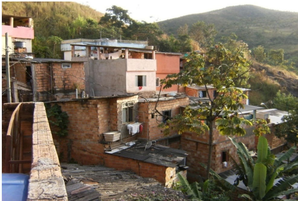
FIGURA 15: Vista da Vila Acaba Mundo. Nota: Podem ser observadas edificações inacabadas, em contínuo processo de construção e ampliação. Fonte: Produzida pelo autor. 2010.
