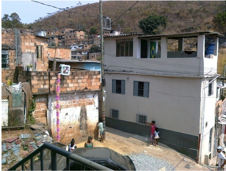
FIGURA 16: Caracterização das edificações. Nota: Contraste em relação ao padrão de acabamento entre as edificações da Vila. Fonte: Produzida pelo autor. 2010
