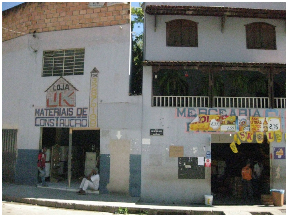
FIGURA 24: Edificação Comercial na Praça Carioca Fonte: Produzida pelo autor. 2010
