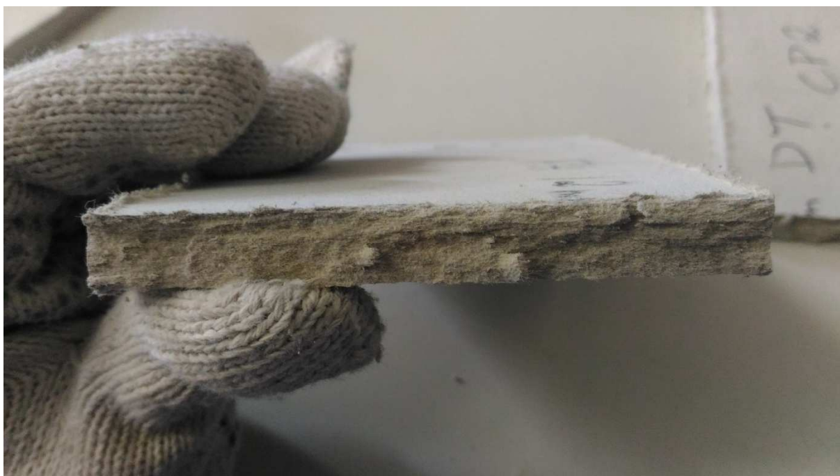
Figura 3.7 - Detalhe da seção da placa cimentícia rompida na seção central do vão.
