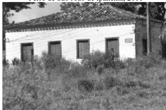
Figura 5. Casa de funcionário da Real Fábrica de Ferro de São João de Ipanema, 2001
