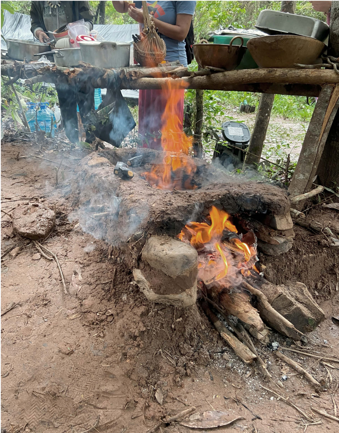
Figura 42 - Fogão de chão finalizado
