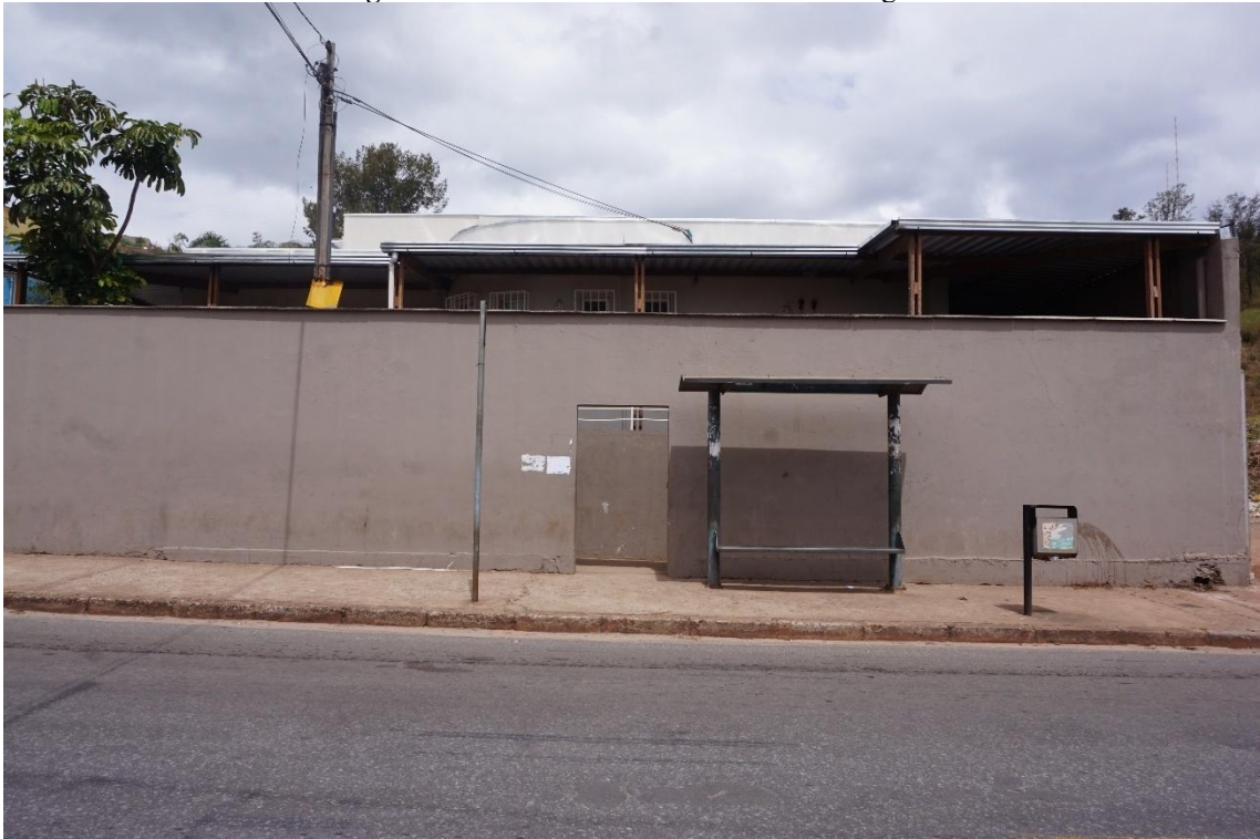
Figura 20 – Centro de Saúde Pilar/Olhos d'Água
