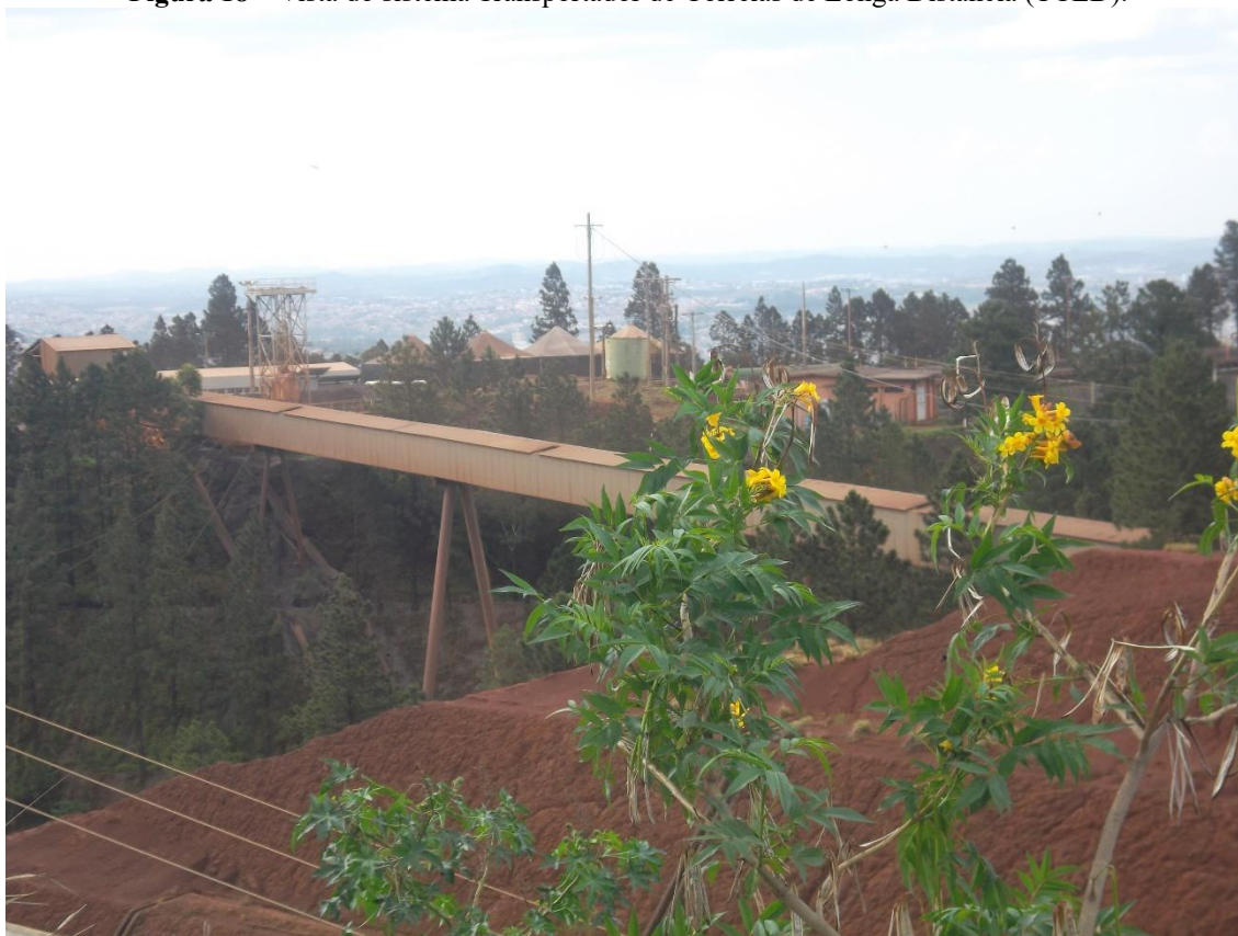
Figura 18 – Vista do sistema Transportador de Correias de Longa Distância (TCLD).
