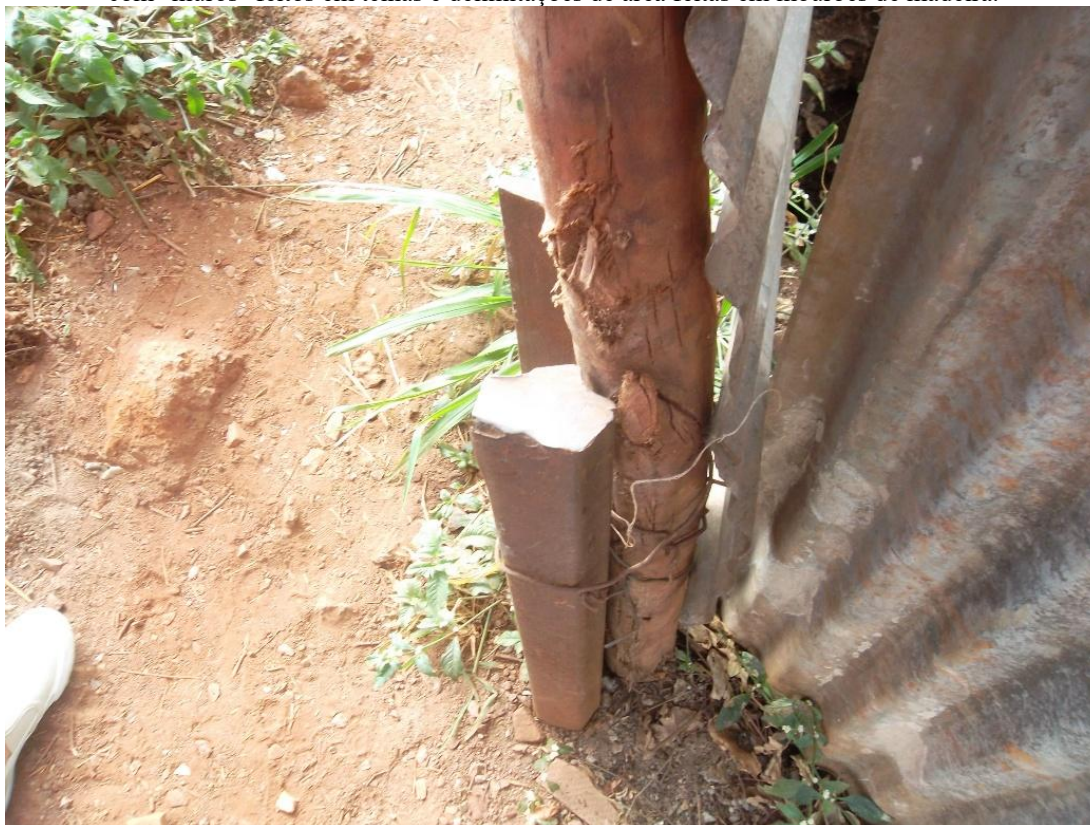
Figura 41 – Área da beira-linha em 2013: o chão era de terra batida, com "muros" feitos em telhas e delimitações de área feitas em mourões de madeira.
