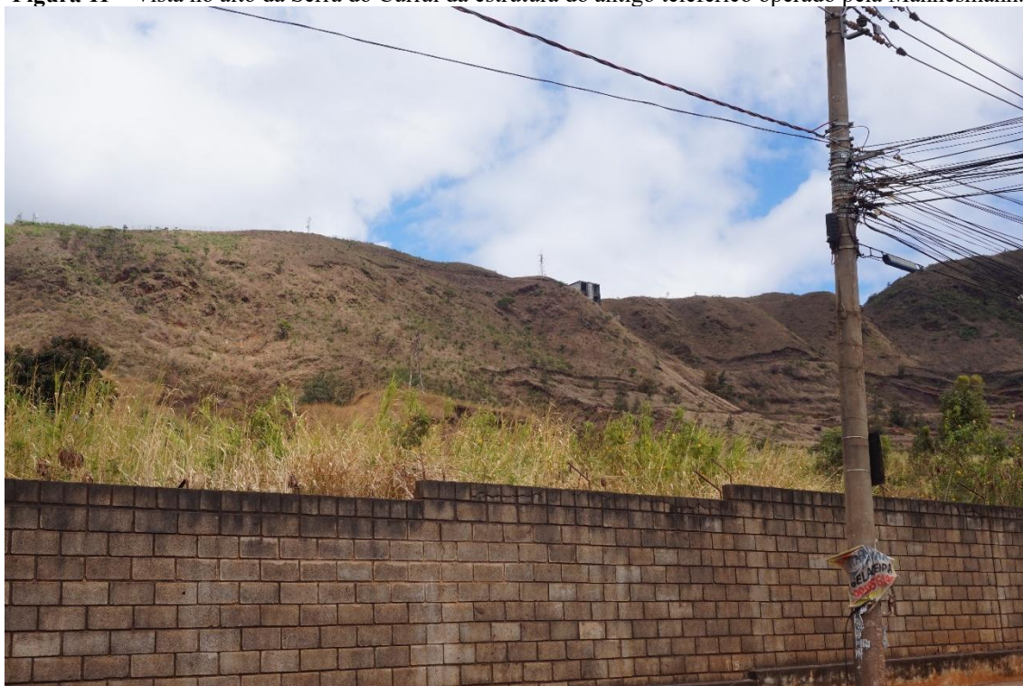
Figura 11 – Vista no alto da Serra do Curral da estrutura do antigo teleférico operado pela Mannesmann.
