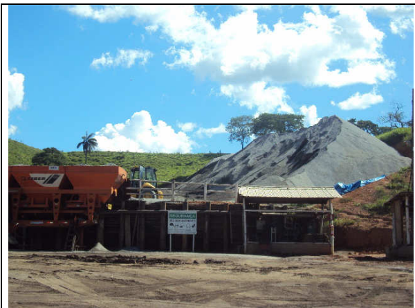
Armazenamento de material
