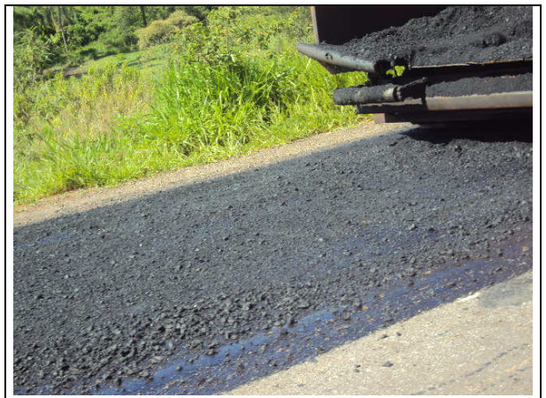
Pavimento sendo recapeado
