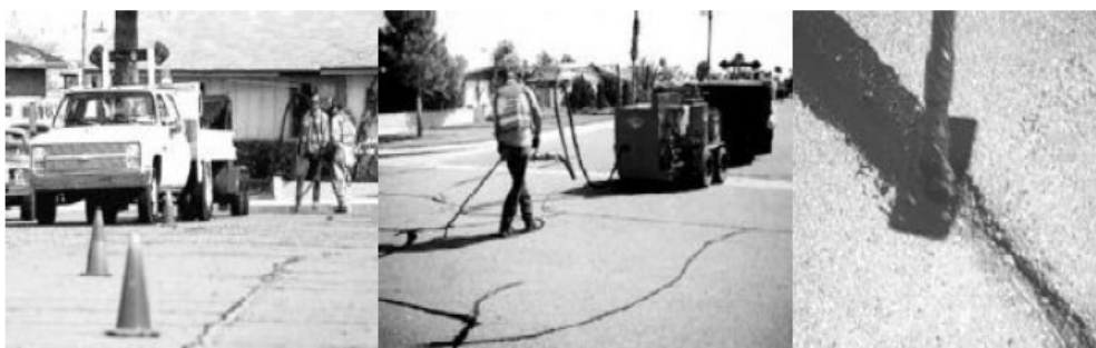
Figura 4.2.5- Aplicação de selagem de trincas. (GRAFTO,1980 apud ODA, 2000)
