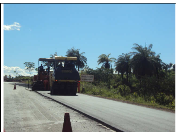
Pavimento sendo recapeado
