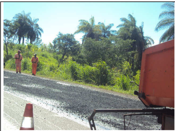
Pavimento sendo recapeado
