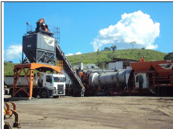
Silo com o material asfático
