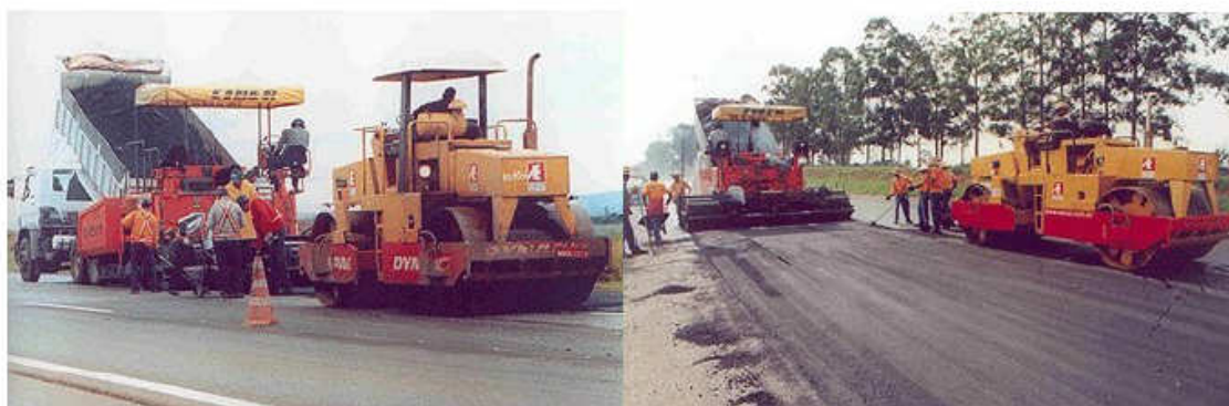
Figura 4.3b- Execução de um Recapeamento (PETROBRÁS, 2003)
