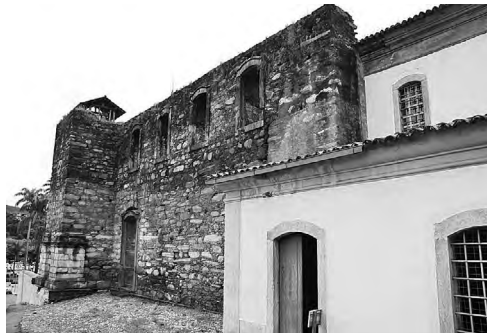
Fig. 14 – Igreja de Nossa Senhora do Rosário dos Pretos, em Sabará, vista interior, com capela original ao fundo. Acervo dos autores, 2016.
