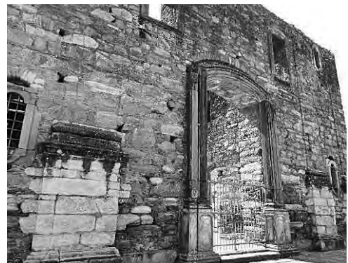
Fig. 12 – Igreja de Nossa Senhora do Rosário dos Pretos, em Sabará, detalhe da portada. Acervo dos autores, 2016.
