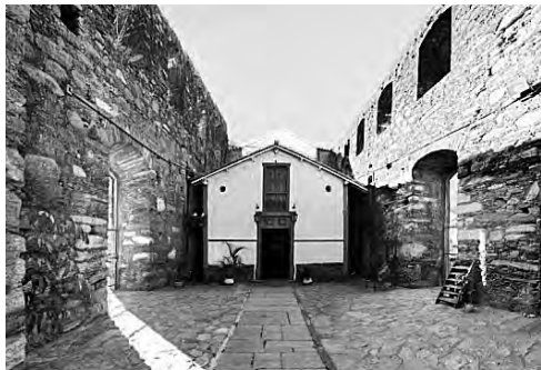
Fig. 13 – Igreja de Nossa Senhora do Rosário dos Pretos, em Sabará, vista lateral esquerda. Acervo dos autores, 2016.
