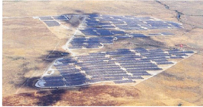
Figura 1.12 Cobertura de nuvens intermitentes em uma planta de energia solar na Espanha. [2] Um parque solar de 23,3 MW em Espanha. Fonte: Suntech.com
