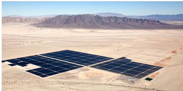
Figura 1.5 Vista aérea da Planta Fotovoltaica de Topaz nos Estados Unidos. Fonte: (First Solar(C), 2014)
