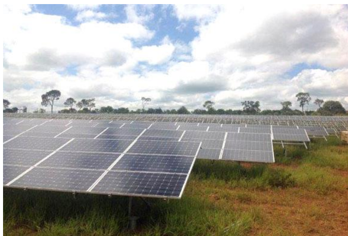
Figura 1.8 Construção da Usina Solar de 3,3 MW de Sete Lagoas - MG. Fonte: CEMIG
