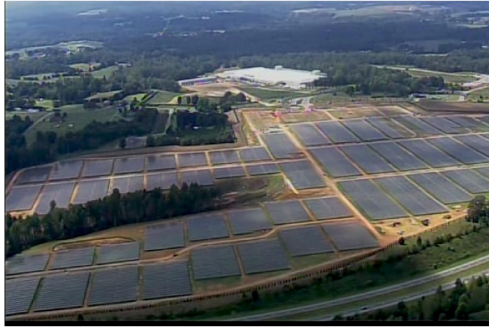
Figura 1.6 Planta fotovoltaica da Apple de 20MW e 0.08 km 2 para alimentação do datacenter do iCloud na Carolina do Norte. Fonte: (Apple, 2014)
