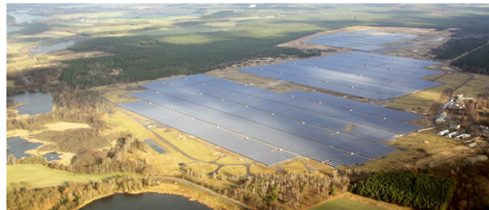
Figura 1.14 Planta fotovoltaica Brandenburg-Briest na Alemanha. Tem capacidade para 91MW gerados por aproximadamente 383.000 módulos de silício cristalino. Fonte: http://www.q-cells.com/
