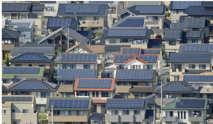
Figura 1.7 Sistema de geração distribuída na cidade de Ota, Japão. Fonte: (Clark, 2010)
