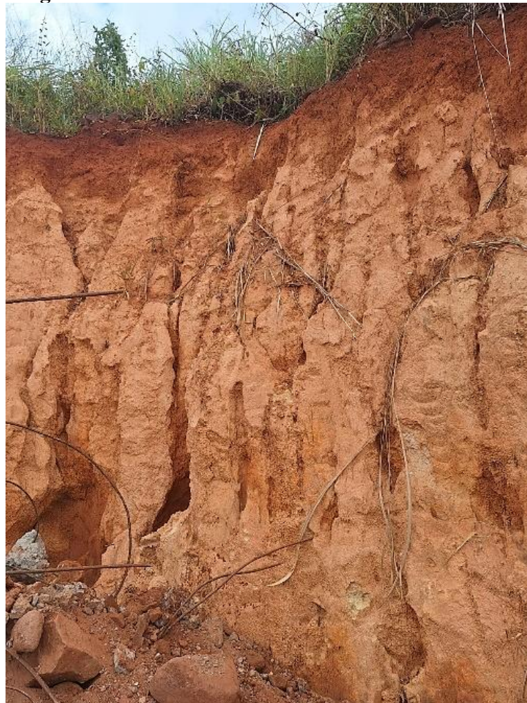
Figura 6 - Erosão em ravinas no Morro dos Cabritos
