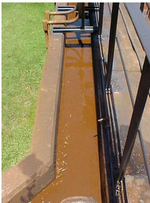
FIGURA 4.2.: RETORNO DO LODO AO TK-02 ATRAVÉS DA BOMBA EM PARAFUSO
