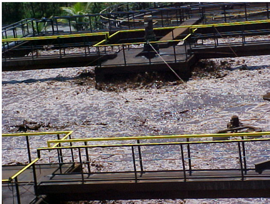
FIGURA 4.8.: VISÃO DO TK-02 COM UM DOS AERADORES MAIORES
