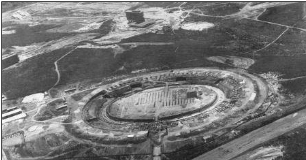
FIGURA 26 – Trabalhos de terraplanagem no terreno onde seria construído o Mineirão. Déc. 1960. Acima na imagem, a edificação da Reitoria da UFMG também em construção.
