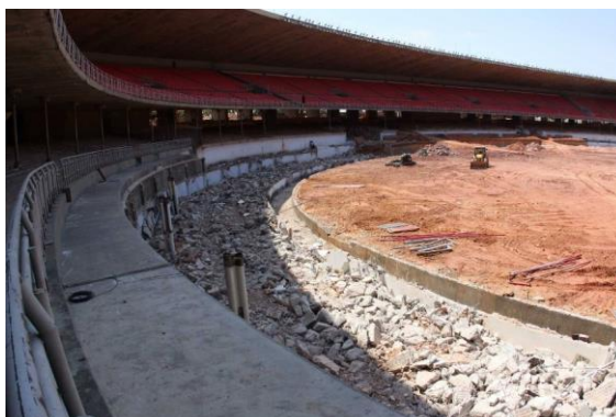
FIGURA 41 – Aspecto interno do Mineirão e demolição de parte das arquibancadas.
