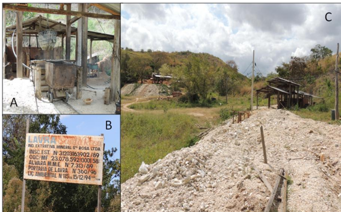
Figura 4.9 – Lavra da Santa Rosa. A. Ponto de acesso ao local de retirada do material da lavra subterrânea. B. Detalhe da placa de entrada da lavra, com dados do processo no DNPM. C. Vista geral da pilha de rejeitos.
