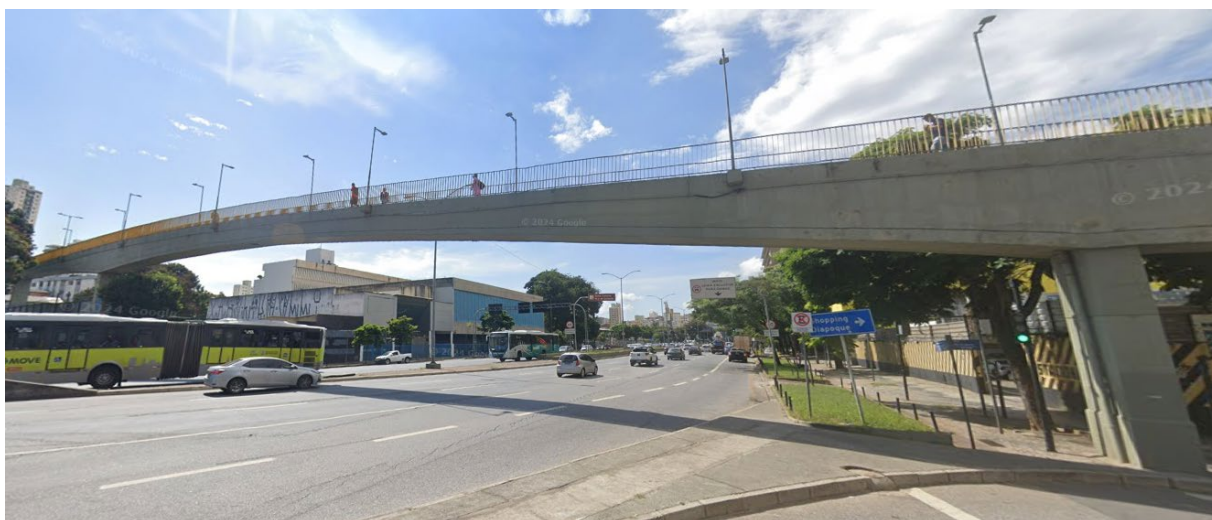
Figura 4.1: Passarela em estudo. (Google, 2024)
