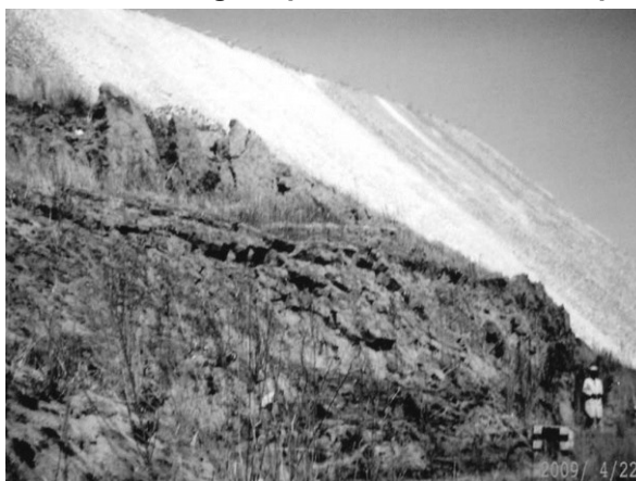
Figura 68 – Superfície final escorregada proveniente de uma ruptura de pilha de estéril
