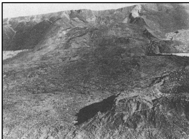
Figura 64 – Fotografia da ruptura da pilha Abercynon, em dezembro de 1939
