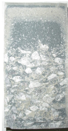
FIGURA 5.2 Segregação ocorrida em alguns exemplares do concreto tipo C.
