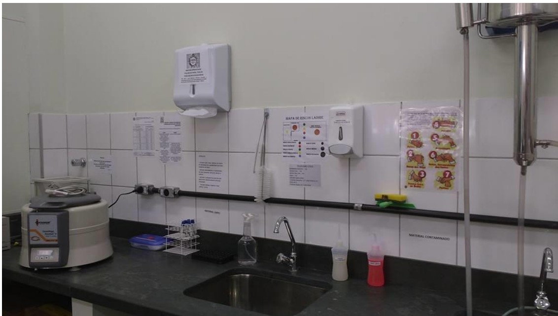
Figura 9: LADIRE – Local de higienização de materiais
