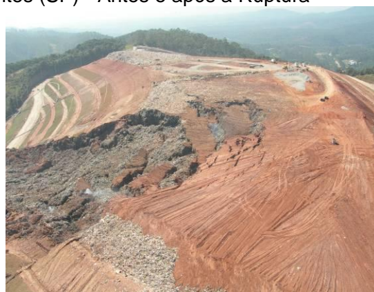
Figura 3.7 - Aterro Sanitário São João (SP) - Após a ruptura
