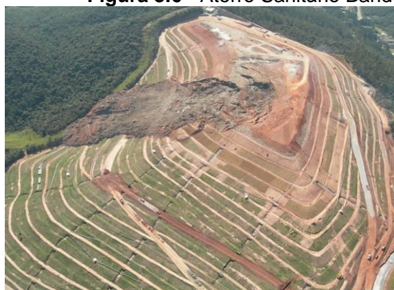
Figura 3.7 - Aterro Sanitário São João (SP) - Após a ruptura
