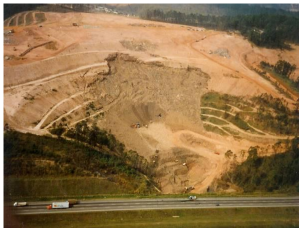
Figura 3.6 - Aterro Sanitário Bandeirantes (SP) - Antes e após a Ruptura
