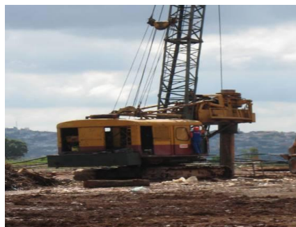
Figura 3.2 - Equipamento utilizado para perfuração de poços de extração de Biogás – Aterro Sanitário BR-040 –BH
