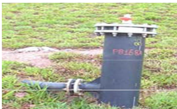
Figura 3.3 - Cabeçote de final de perfuração e conexões para extração de biogás - Aterro Sanitário Bandeirante (Kaimoto, 2004)
