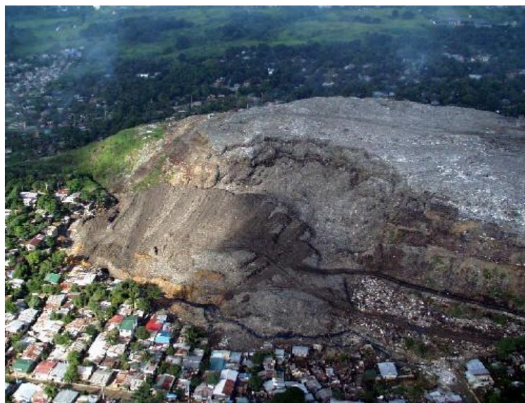
Figura 3.8 - Vista do escorregamento aterro Payatas - Filipinas
