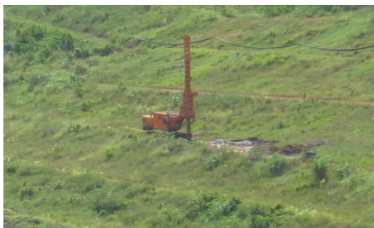
Figura 3.1 - Equipamento utilizado para perfuração de poços de extração de Biogás – Aterro Sanitário BR-040 – BH
