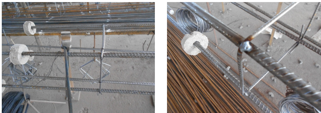
Figura 2.1 – Evolução da turquesa e arame recozido para a solda ponto MIG (Ralf Schuttenberg, 2013)
