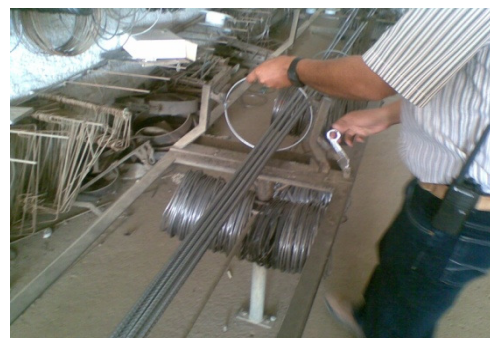
Foto 6.4 – Bancada gabaritadas e posicionadores de estribos. (Ralf Schuttenberg, 2013)
