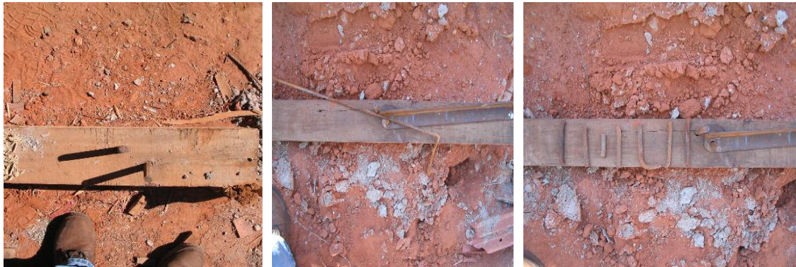
Figura 1.5 – Sequência de fotos de sistema de dobra ainda existente em algumas obras (Ralf Schuttenberg, 2005)
