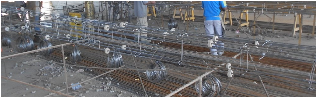
Figura 5.1– Poste tipo DT 11 / 300 (Ralf Schuttenberg, 2013)
