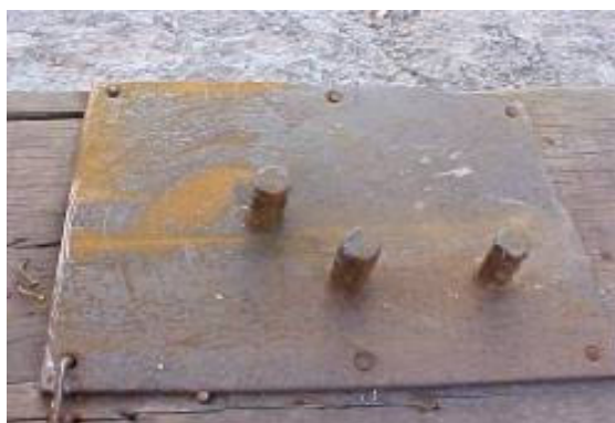
Figura 3.3- Dobramento manual da armadura em canteiro – pinos (BOTTURA & MELHADO, 2006)
