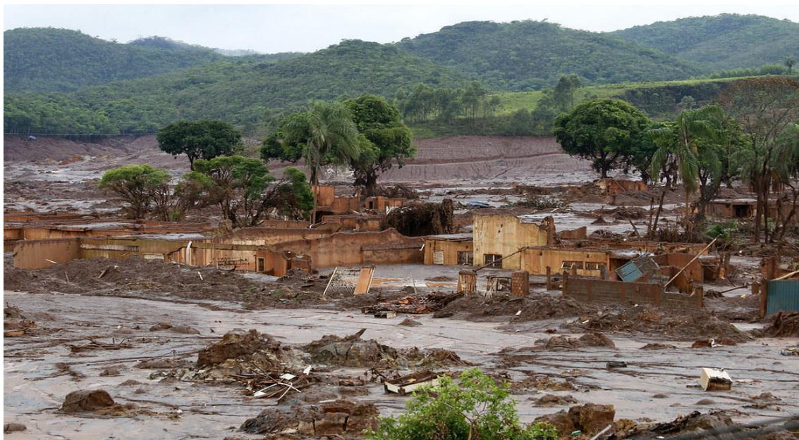
Figura 1 - Bento Rodrigues após o rompimento da Barragem de Fundão em 2015.
