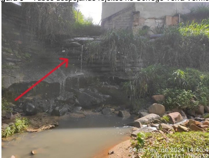
Figura 3 – Tubos despejando rejeitos no Córrego Terra Vermelha
