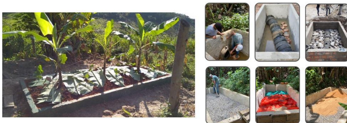
Figura 18 – Tanque de Evapotranspiração
