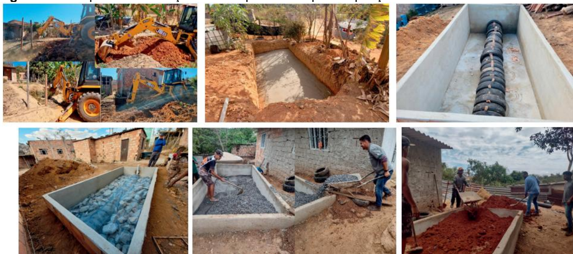
Figura 17 – Etapas de construção dos tanques de evapotranspiração nas residências selecionadas
