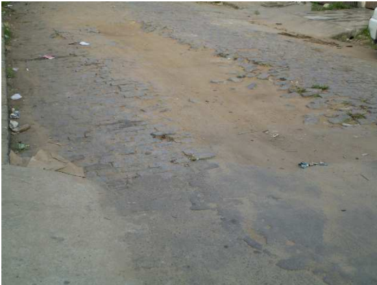
Fotografia 1: esgoto em Custodópolis
