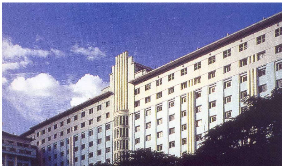
FIGURA 27: Exemplo de frisos geométricos que dão ritmo à fachada, definem o prédio como “moderno” para a época e hierarquizam a entrada principal. Edifício Santa Casa da Misericórdia – Belo Horizonte
