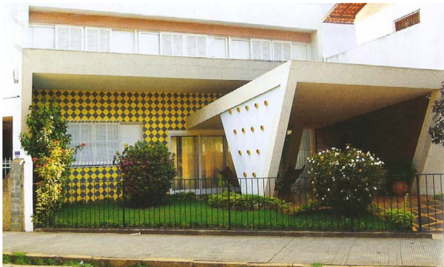
FIGURA 59: Fachada de residência em Cataguases – MG
