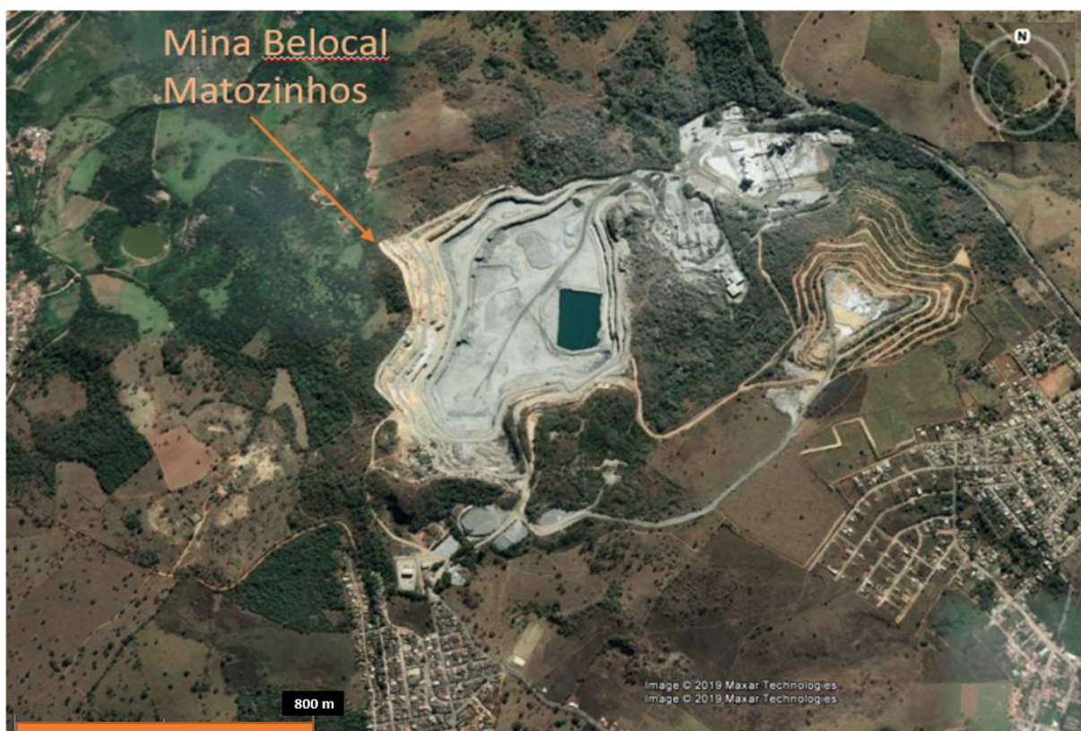
Figura 1: Vista aérea da região da Mina de Matozinhos (Google Earth).
